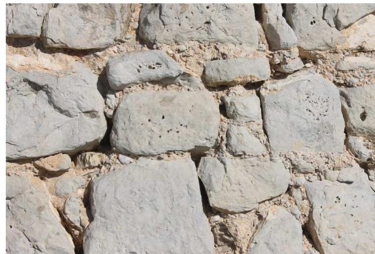
Zona erosionada del muro perimetral de la torre
