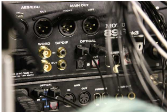
Figura 54. Conexionado por fibra óptica.
