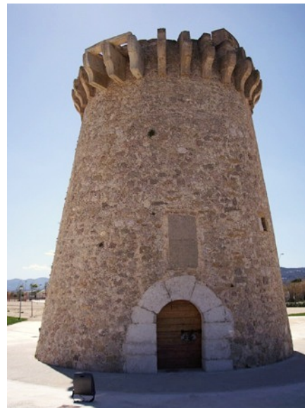
Torre de Piles, Piles.
