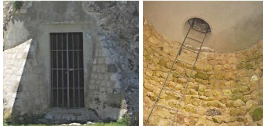
Detalle puerta de acceso y escalera interior, (2013).
