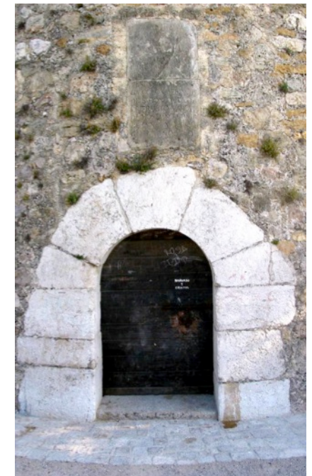
Torre de Piles antes de su última intervención (2003) Fuente: www.cult.gva.es
