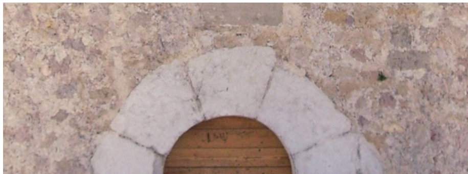
Detalle dovelas puerta de acceso, Torre de Piles 2012
