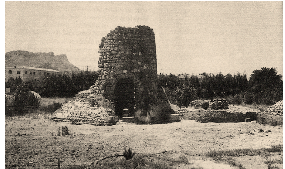
Estado ruinoso que presentaba la torre y el aljibe situado a la derecha antes de su reconstrucción y la urbanización de la zona en 1995. Fuente: BANYULS PÉREZ, Antoni; BOIRA MAIQUES, Josep Vicent; LLUESMA ESPANYA, Josep Antoni, Arquitectura i control del territori. La defensa del litoral de la Marina Alta al segle XVI , (1996).
