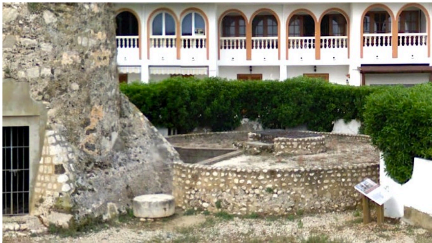
Restos de la instalación de abastecimiento de agua adosada a la torre, (2013).
