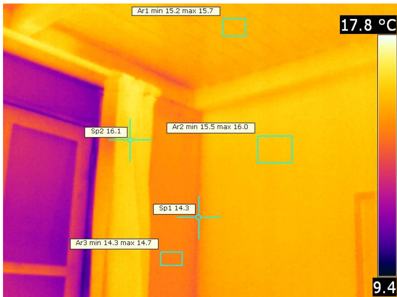
Imagen IR 4.12. Interior dormitorio. Fachada Oeste y Norte.
