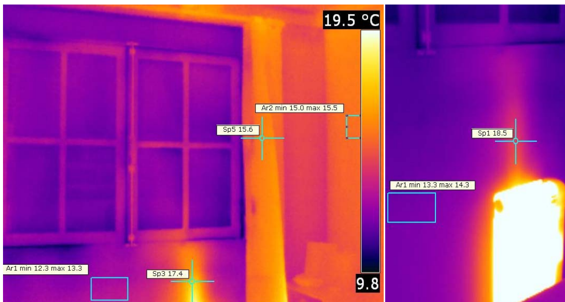
Imagen IR 4.11. Ventana interior de dormitorio. Fachada Norte.
