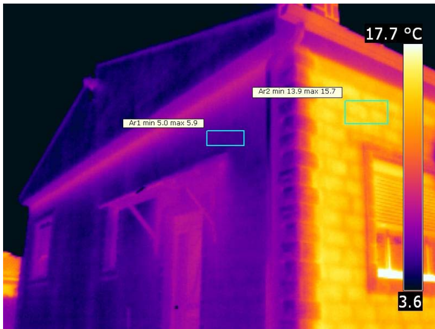
Imagen IR 4.6. Fachada Oeste y Sur.
