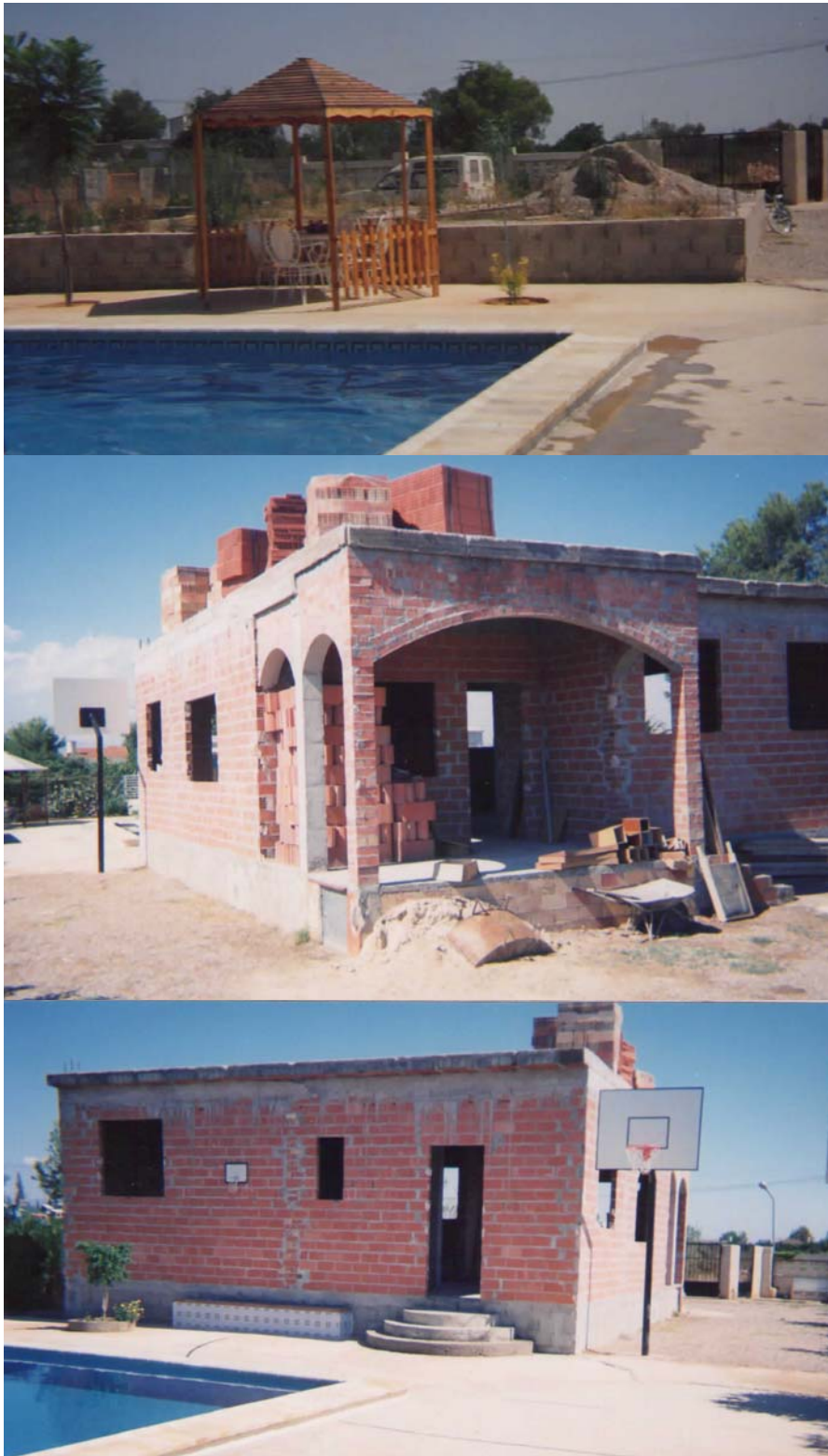
Figura 2.7. Fotos fase de ejecución del edificio
