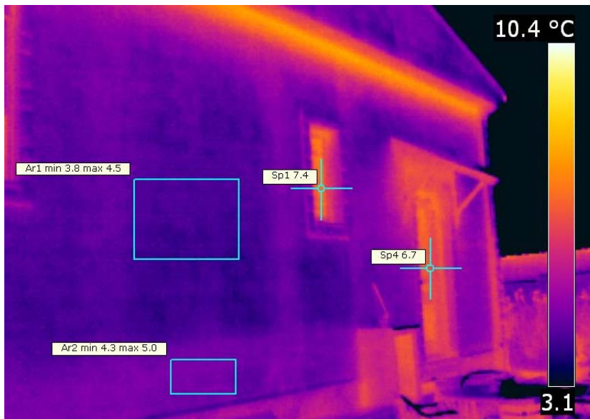
Imagen IR 4.5. Fachada Oeste.
