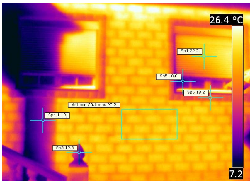
Imagen IR 4.2. Fachada Este.
