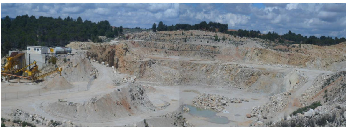
Fotografía N° 8: Vista panorámica de la parcela todavía en explotación
