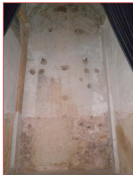
Fotografía 76 – Estado actual capillas.
