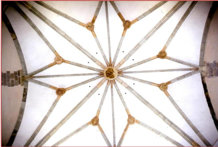
Fig. 32 - Bóveda de crucería sala capitular.
