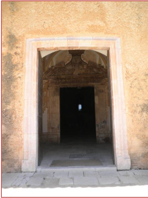
Fotografía 72 – Detalle acceso atrio.
