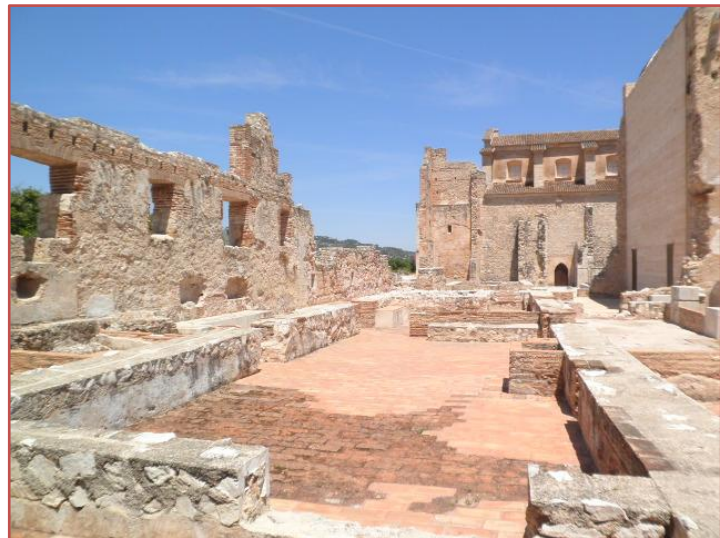
Fotografía 19 – Estado actual de la Obra Nueva
