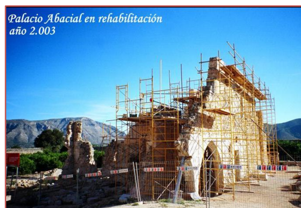
Fig. 10 – Rehabilitación Palacio del abad.
