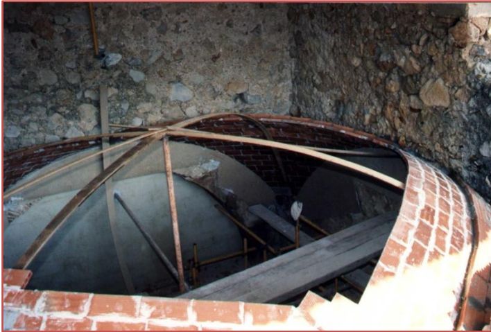
Fig.59 Ejecución de la cúpula de la sacristía.
