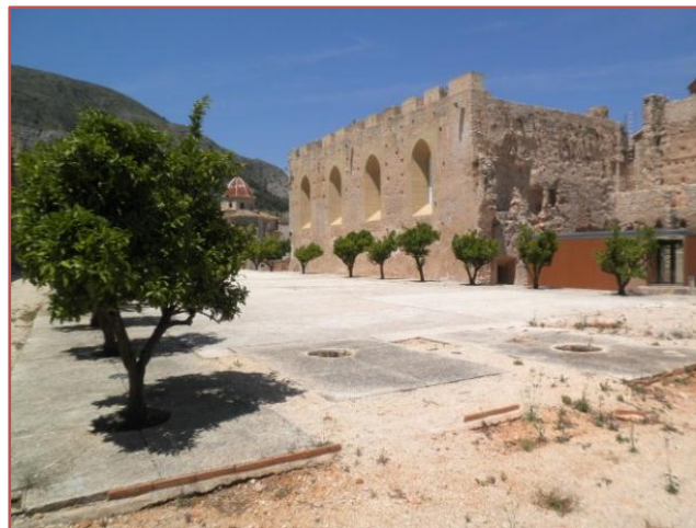
Fotografía 24 – Muro sur del Refectorio.
