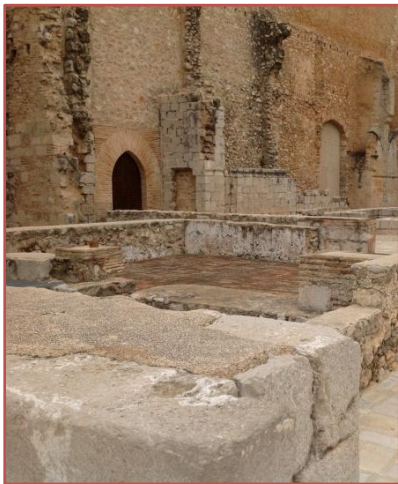
Fig.52 Puerta 5ª capilla exterior.
