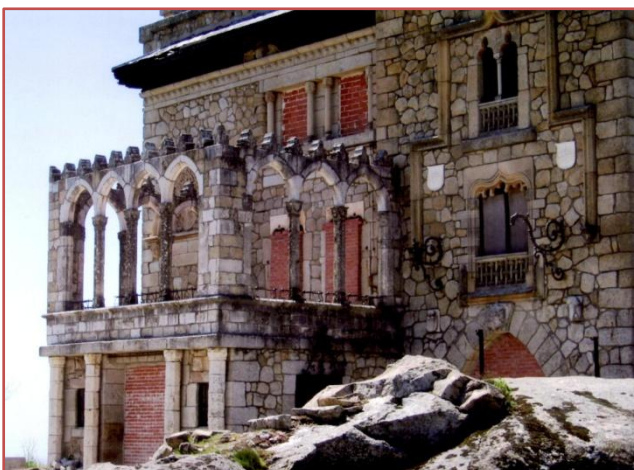
Fig. 36 - Palacete de Torrelodones donde se encontraba el palacio del abad.
