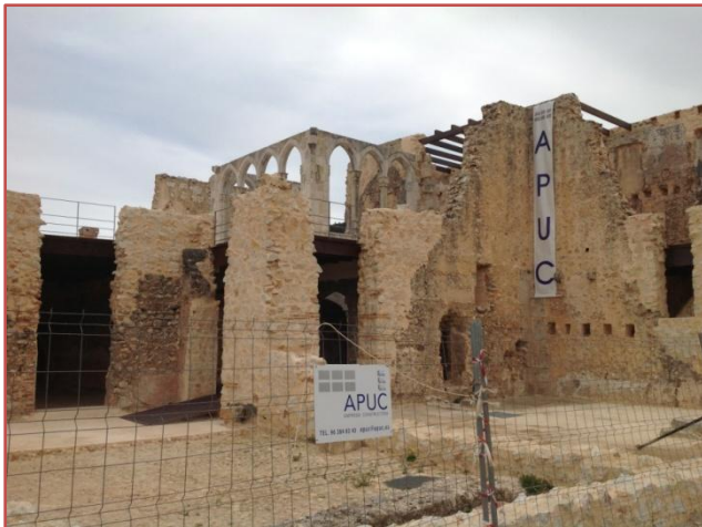
Fotografía 30 – Estado actual del Palacio del abad.
