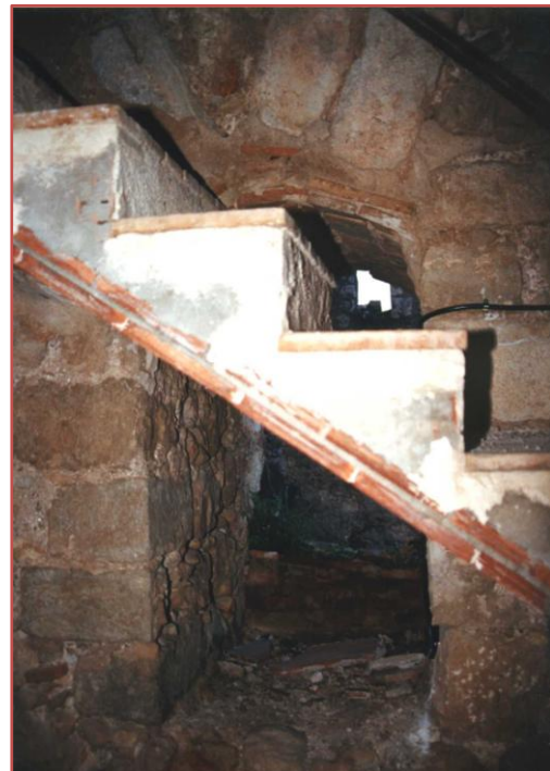
Fig. 67 - la escalera bloquea un de los huecos de la base de la torre campanario. Se supone que la escalera originaria pasaba por aquí.
