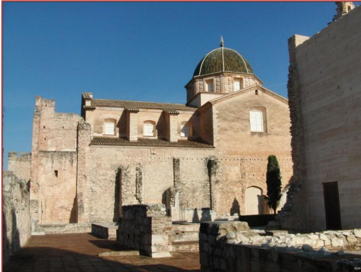
Fig. 38 - Restos del segundo templo adosados al muro de la iglesia actual.
