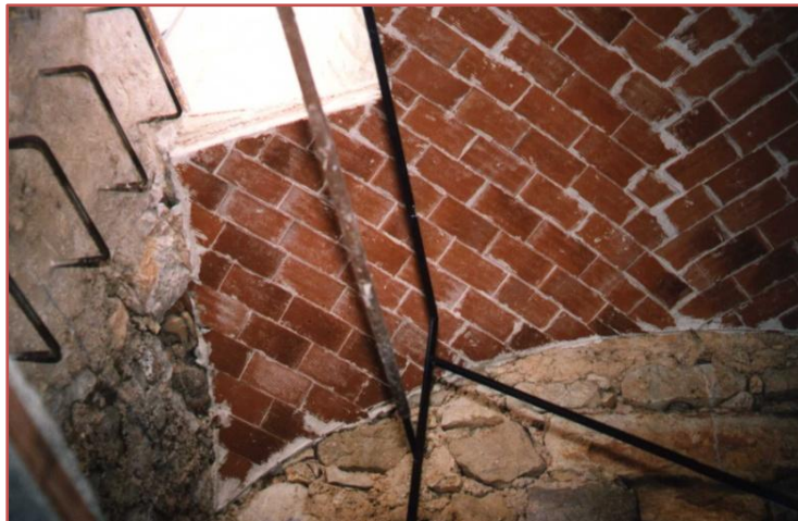
Fig. 72 - Bóveda en ejecución para dividir el primer cuerpo del campanario del segundo. Se accede directamente desde la escalera de la caña de la torre.
