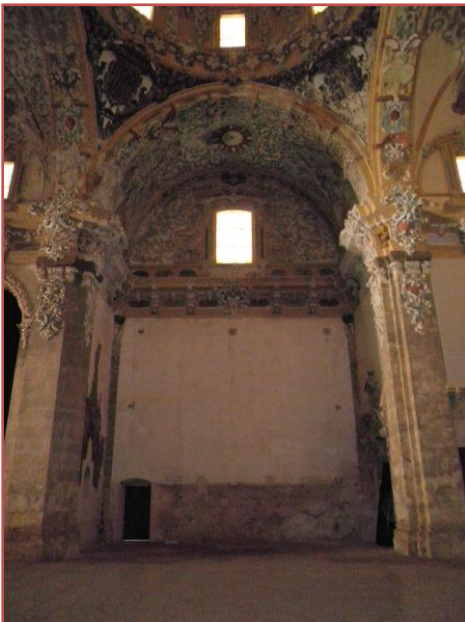
Fotografía 63 – Muro del crucero.
