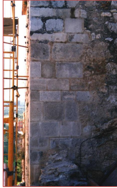
Fig. 70 - El agujero del campanario ya reparado.
