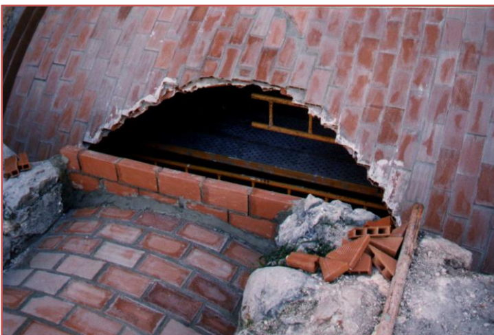
Fig.61 Ejecución de la bóveda del trasaltar.
