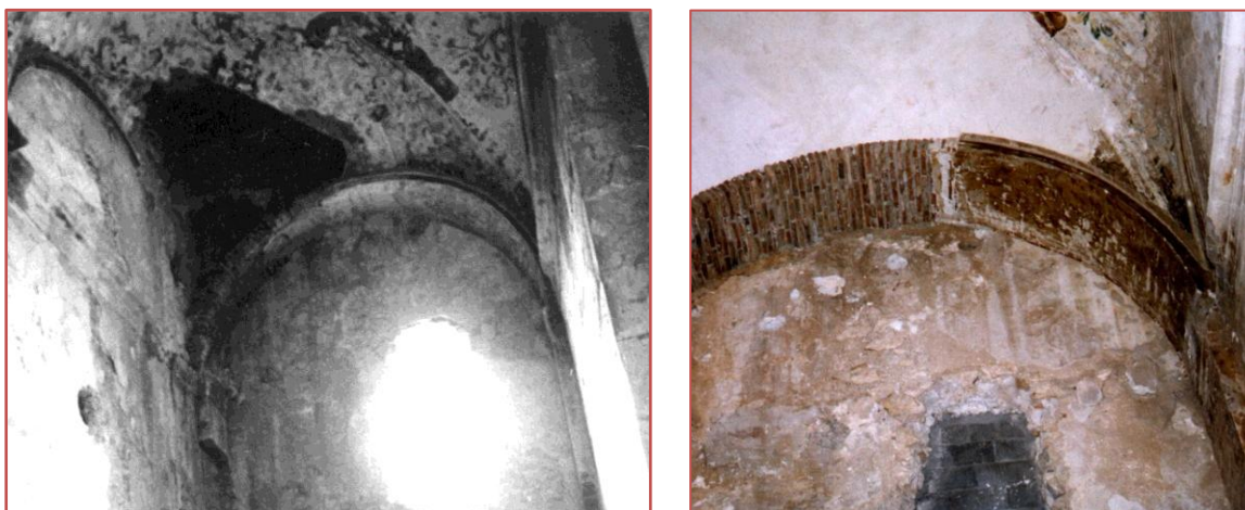
Fig.46 Reparación de la cubierta de la 4ª de las capillas (izquierda) y acabado final (derecha).
