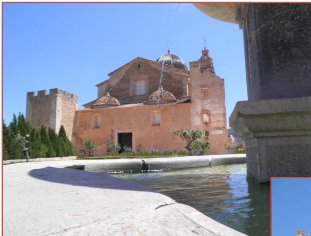
Fotografía 52 – Fachada principal (oeste).
