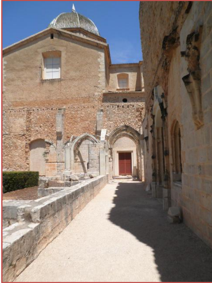
Fotografía 21 – Pasillo Este del Claustro
