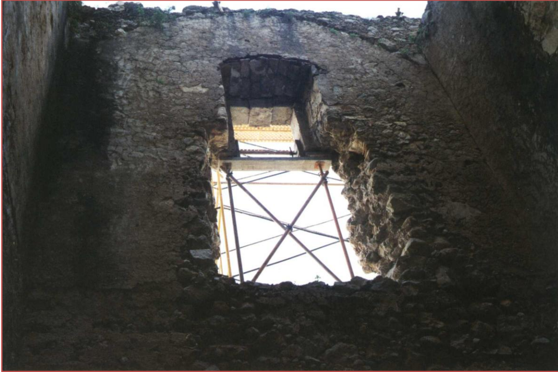
Fig.56 Apuntalamiento de emergencia en el muro Norte.
