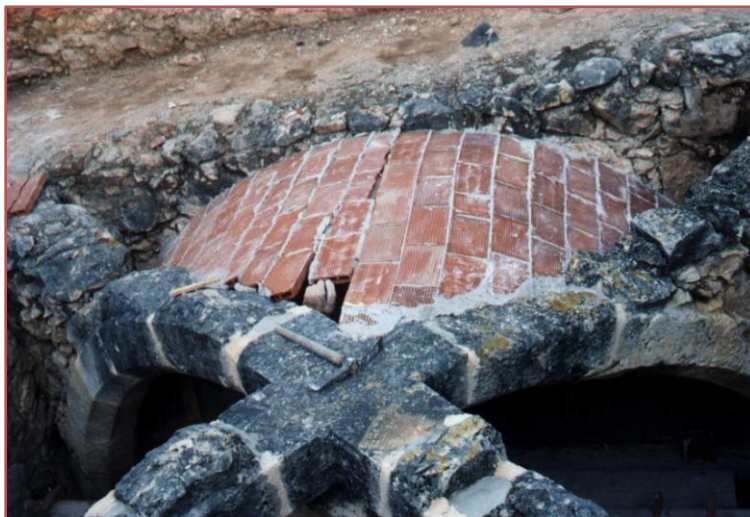
Fig.65 Bóveda de crucería de la torre durante de la restauración.
