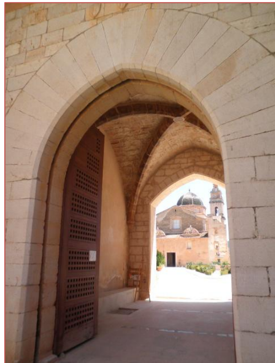
Fotografía 8 – Acceso principal a través del “Portal Nou”
