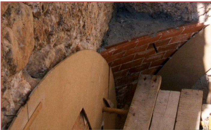
Fig.58 Cimbra para la cúpula de la sacristía.
