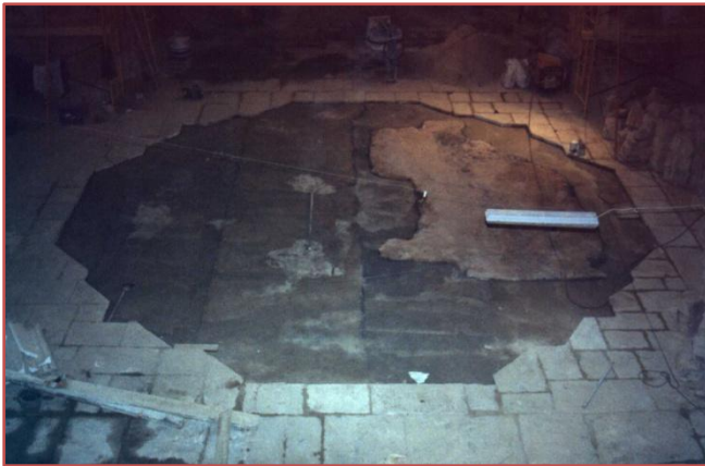
Fig. 77 – Reposición del pavimento del crucero tras las excavaciones.
