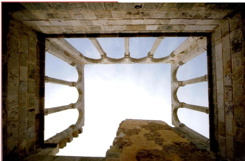
Fotografía 32 – Sobreclaustro encontrado en el palacete de Torrelodones.
