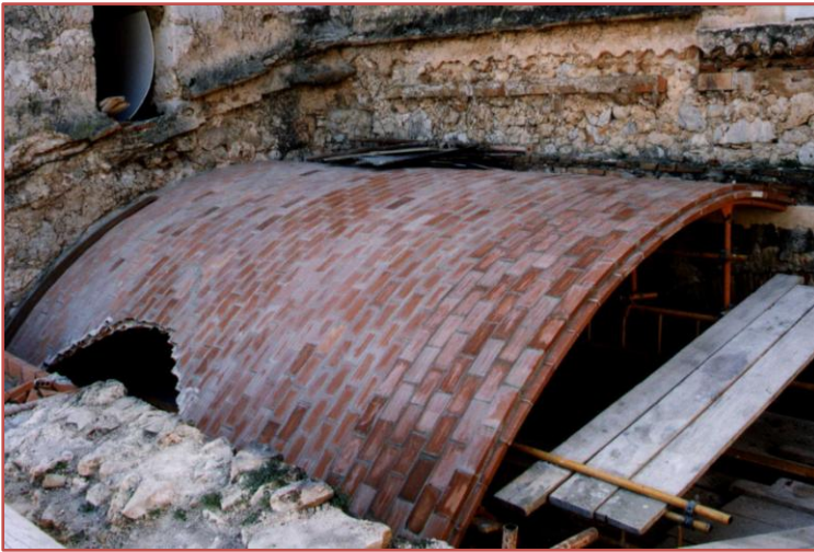
Fig.60 Ejecución de la bóveda del trasaltar.
