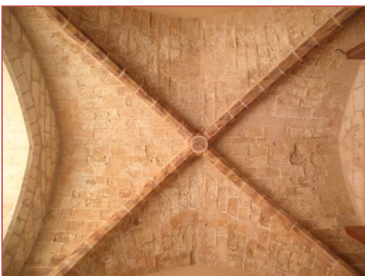
Fotografía 9 – Bóveda de crucería del “Portal Nou”.
