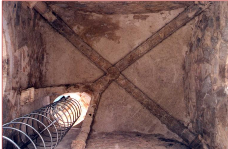
Fig. 71 - Bóveda superior del segundo cuerpo. Se trata de la bóveda esquinada característica que se encuentra en el monasterio para permitir el paso al nivel superior. Se colocó una escalera de patés para ascender.
