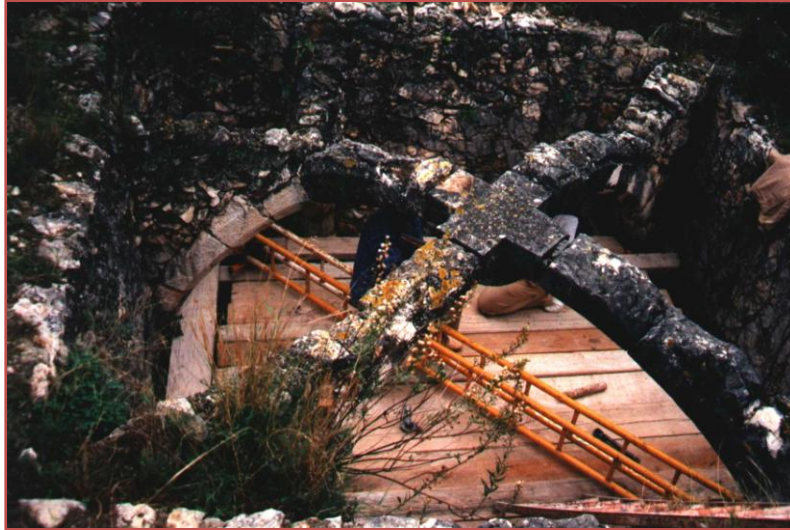
Fig.64 Bóveda de crucería de la torre antes de la restauración.
