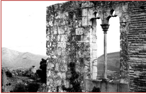
Fotografía 33 – Ventana Palacio del abad.
