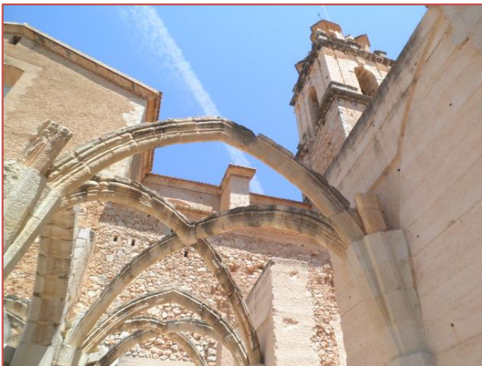
Fotografía 20 – Reconstrucción de parte del Claustro del silencio.
