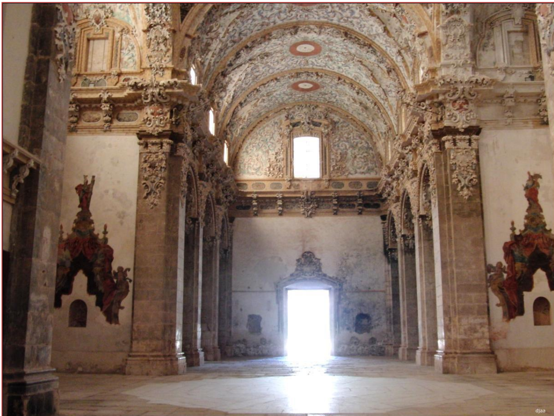
Fig. 41 - Imagen interior de la Iglesia donde se observan las pinturas.
