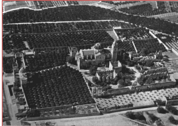
Fotografía 34 – Imagen aérea del monasterio.
