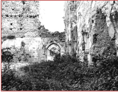
Fotografía 41 - Claustro y Locutorio.
