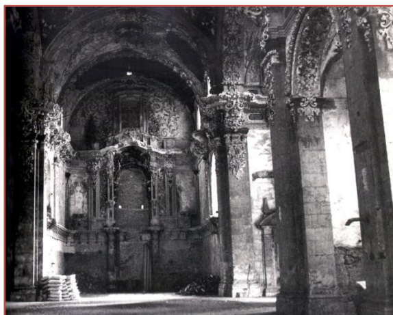
Fig. 9 – La Iglesia utilizada como almacén.
