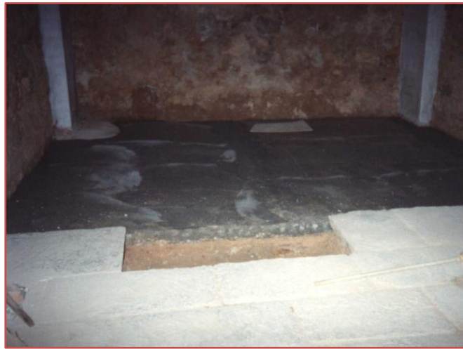
Fig.47 Reposición del pavimento en una de las capillas.
