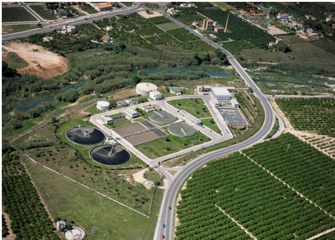
Figura 2. Vista aérea de la EDAR de Gandía
