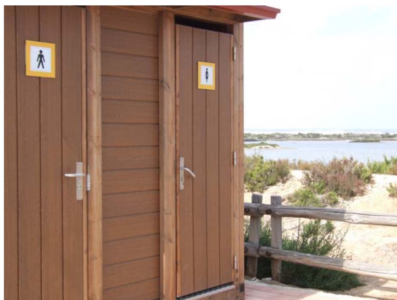
Figura Nº 35: Aseos públicos en el Parque Regional Salinas y Arenales de San Pedro del Pinatar, incluida cabina para minusválidos en Área Recreativa “El Coterillo”
