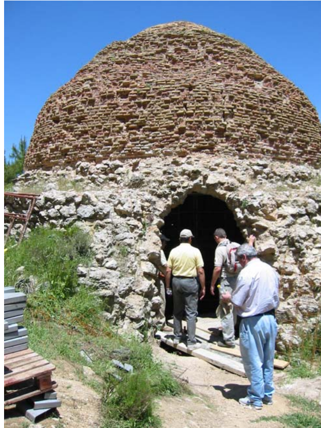
Figura Nº 22. Los pozos de la nieve en Sierra Espuña. Fotografía de uno de los pozos de nieve en el Parque Regional Sierra Espuña, construidos en el siglo XVI para fabricar hielo.
