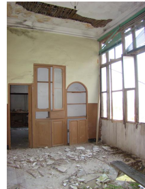
Figura III. Estado inicial del interior del Palacio.
