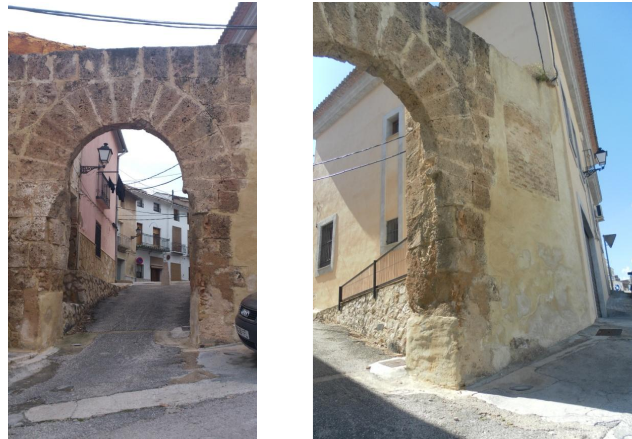
Figura VII. Composición de la puerta de Valencia, incluso intervenciones posteriores.
