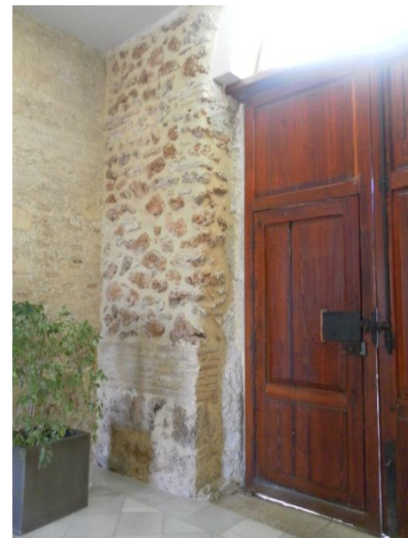
Figura X. Vista de los estribos desde el interior del Ayuntamiento.
