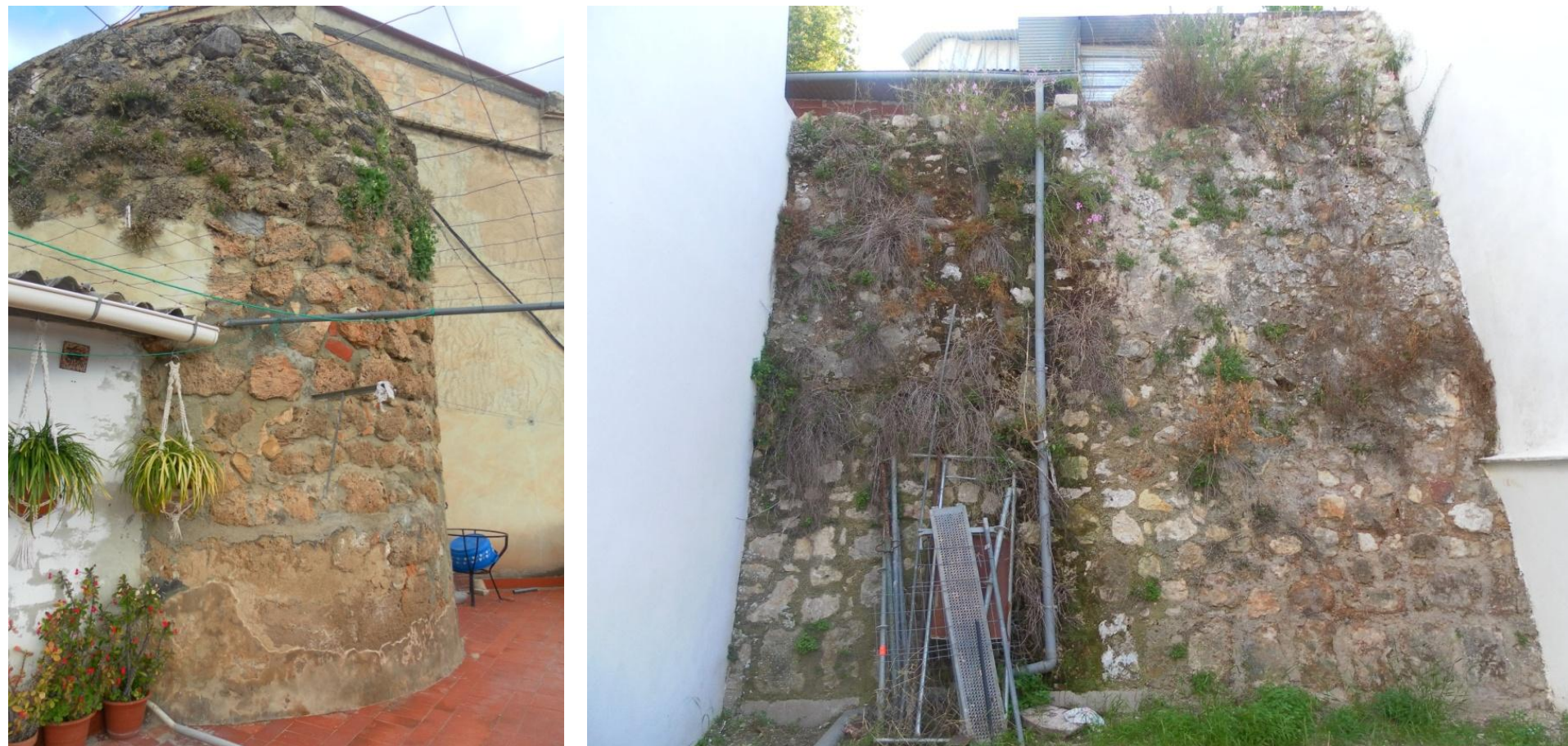
Figura V. Ejemplos de mampostería en las murallas de Albaida, la torreta de Guaita y el lienzo de muralla.
