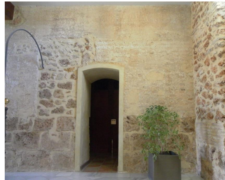
Figura XI. Tramo de la muralla en el interior del Ayuntamiento.
