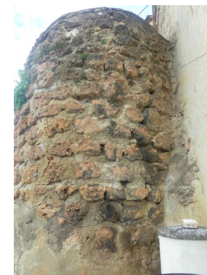
Figura VIII. Estado actual de distintas partes de la muralla de Albaida, donde se puede observar la falta de material de agarre en las juntas.
