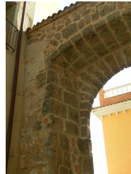
Figura VIII. Combinación de un arco de medio punto en la parte delantera y uno de escarzano en la parte interior.
