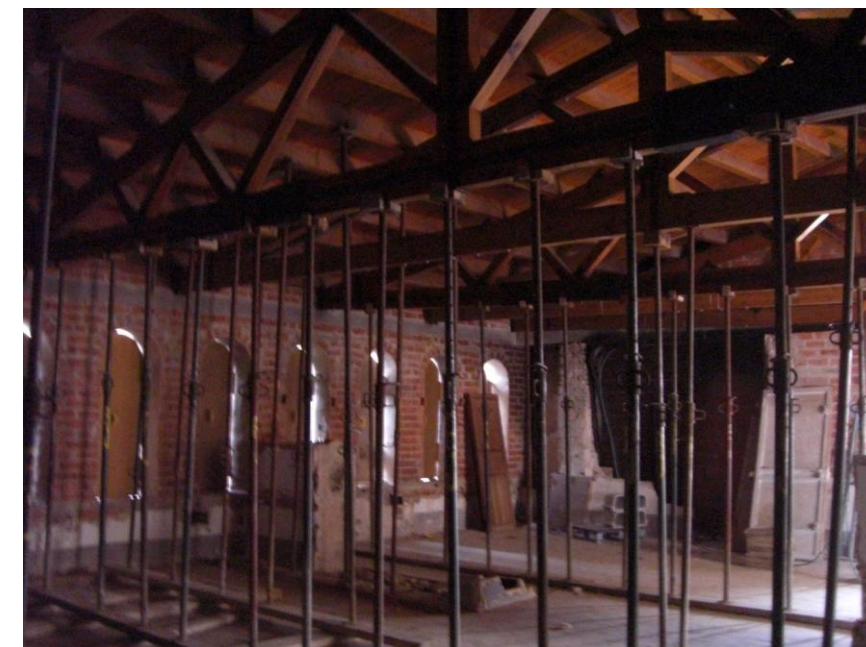
Figura V. Ejecución de las obras en el interior del Palacio.
