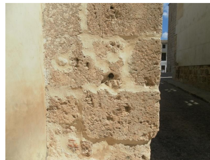
Figura VIII. Estado actual de distintas partes de la muralla de Albaida, donde se puede observar la falta de material de agarre en las juntas.
