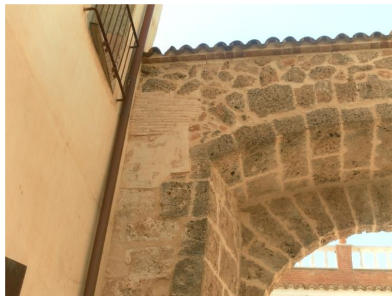
Figura XI. Estado actual de la Puerta de la Vila, con un tejadillo como protección.
