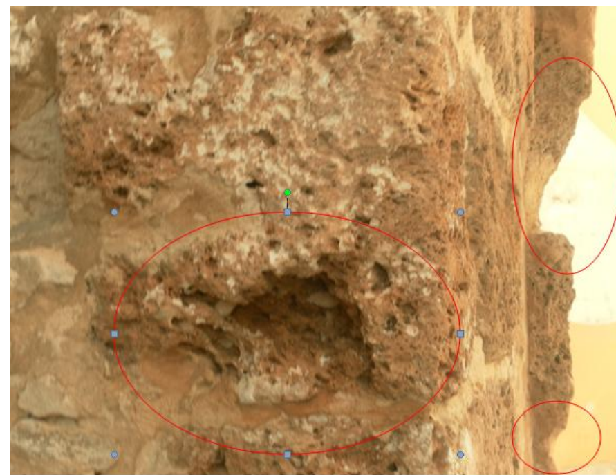
Figura VI. Disgregaciones o desagregaciones.
