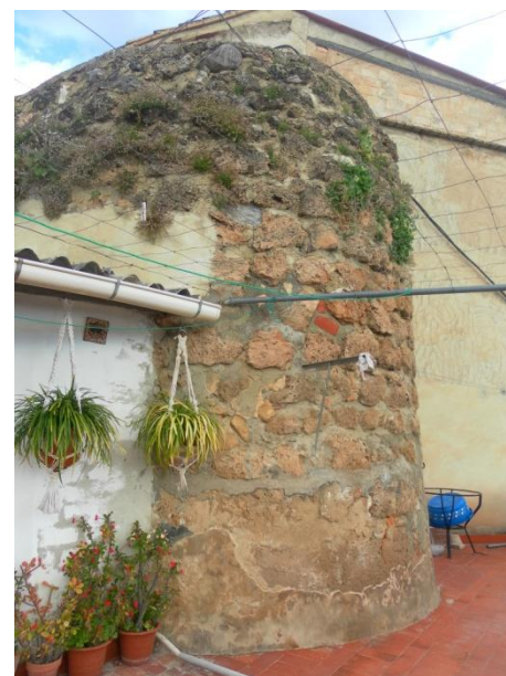
Figura XIX. Torreta emplazada en la terraza.
