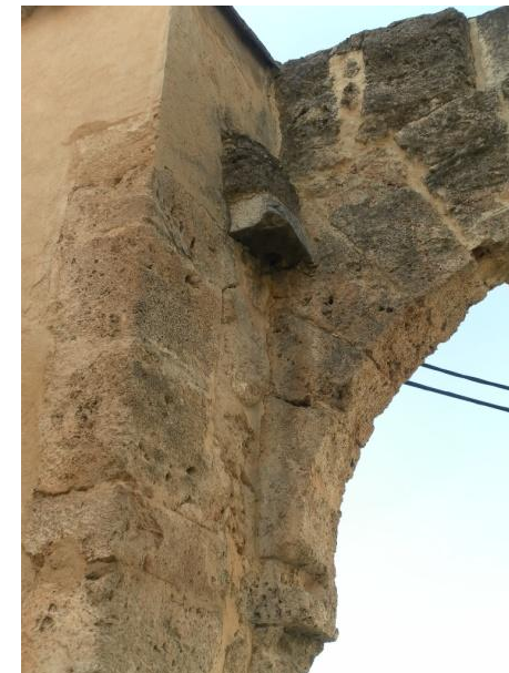
Figura XVII. Detalle de la mocheta.
