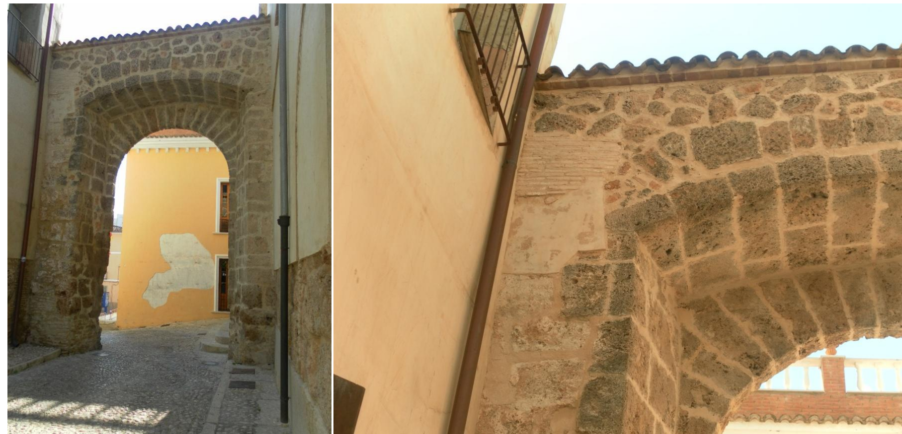
Figura VI. Composición de la puerta de la Vila, se pueden observar los distintos materiales empleados incluso en las intervenciones posteriores.
