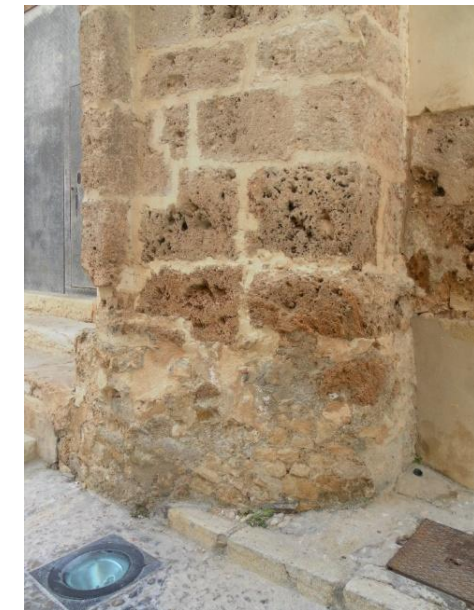
Figura IX. Estribos del arco.
