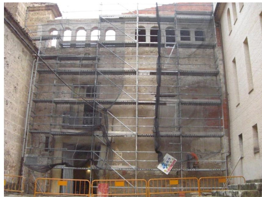
Figura IV. Ejecución de las obras en las fachadas posteriores del Palacio.
