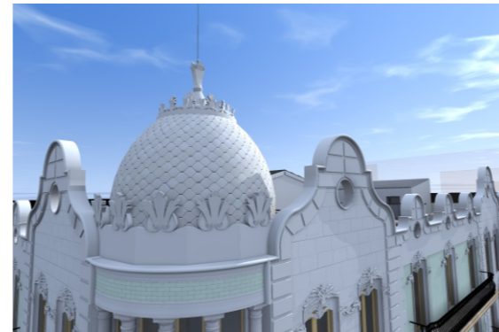
8:40 Comienza a proyectarse el sol sobre la fachada recayente a Peris y Valero.
