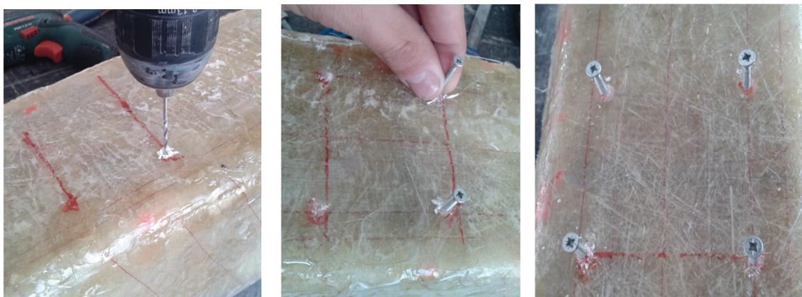
Fotografía 4.123., 4.124. y 4.125. Colocación de conectores en parte superior de la viga
