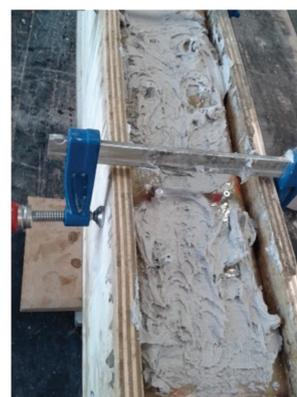
Fotografía 4.130. y 4.131. Preparación del adhesivo      Fotografía 4.132. Colocación adhesivo
