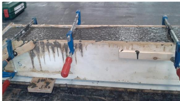
*Fotografía 4.137. Vertido del hormigón 2*
