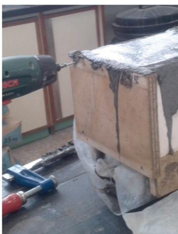
Fotografía 4.140. y 4.141. Retirada del encofrado
