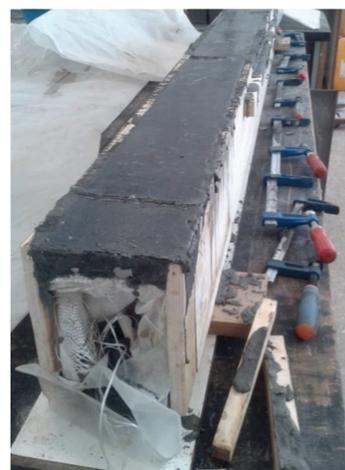
Seguidamente, y una vez las tablas solo quedan ancladas en su sitio por la adhesión al hormigón, con la ayuda de una espátula y una maza se extraera la madera de los laterales, quedando la viga hormigonada exenta de medios auxiliares (ver fotografía 4.142).
