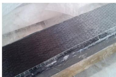
Fotografía 4.118. y 4.119. Última capa de carbono con resina epoxi
