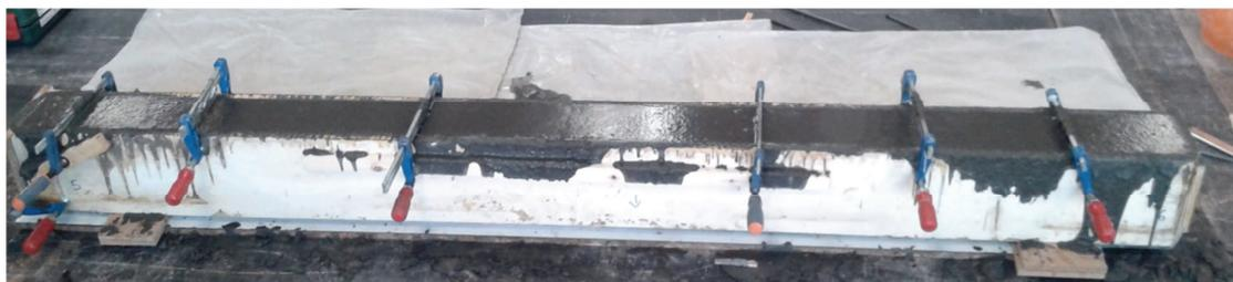
*Fotografía 4.138. Viga hormigonada con encofrado*
