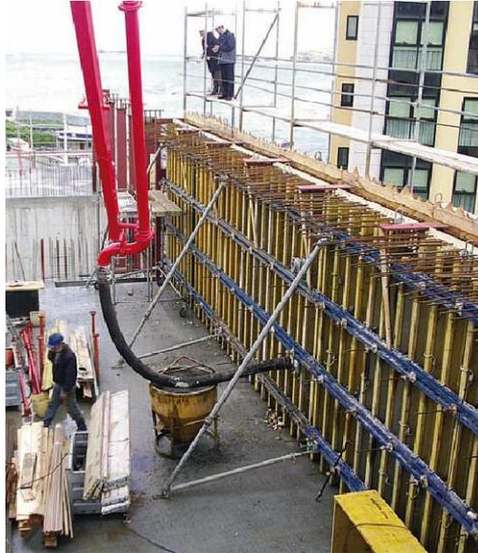
**Imagen 3.27 Encofrado y colocación de hormigón autocompactante mediante bombeo tradicional. (HAC. Criterios para su utilización) [15]**
