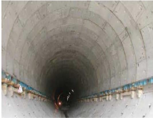
**Imagen 1.10 "Túnel hormigón con fibras" (A.Aguado) [7]**
