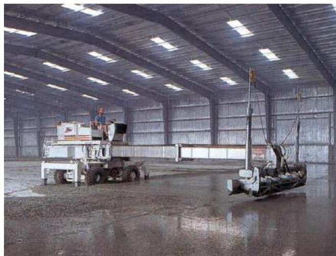
Imagen 1.9 Solera hormigón con fibras. (Hormigones Reforzados con fibras. E. Torroja) [6]
