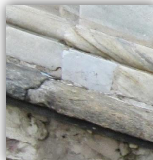
Reintegración con Mármol de Carrara
