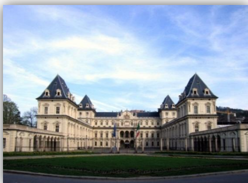
Fachada hacia Torino
