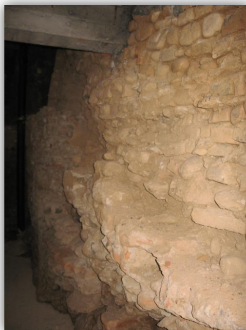
Vista del muro basamental por su cara interior.
