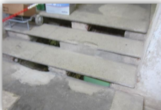
Escalera de acceso al sótano desde el Atrio del Patio
