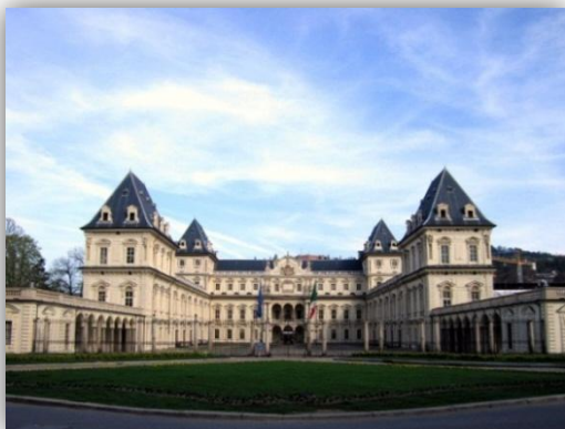
Fachada hacia Torino revocada.
