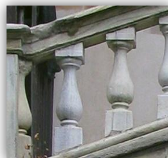
Izquierda, mármol de Prali de rehabilitación. Derecha, mármol de San Martino original.
