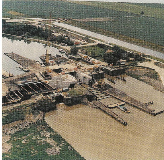
Fotografía 2.2. Compuerta de Almelo
