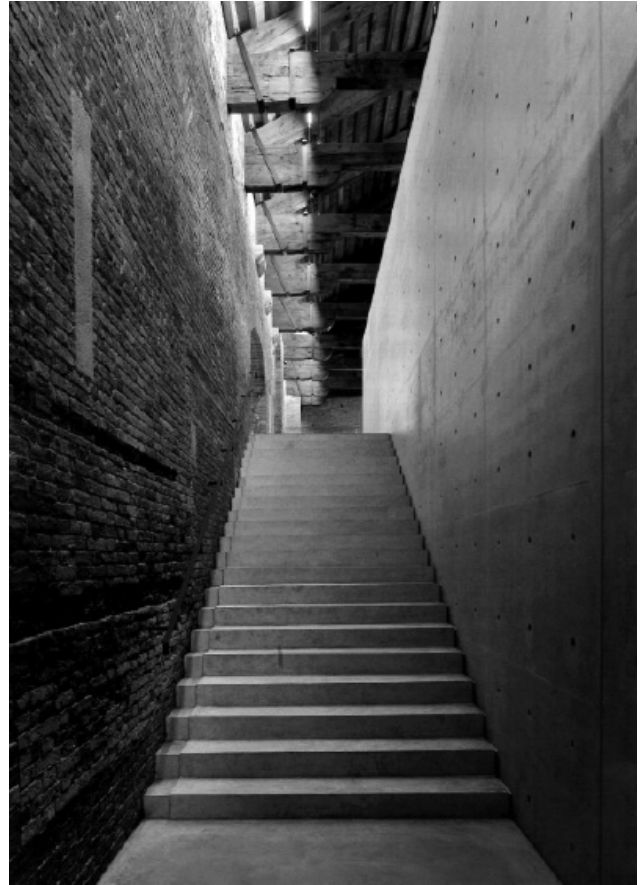
Figura 9. Relación de los antiguos muros de ladrillo con el núcleo de hormigón de Ando. Fotografía de la autora
