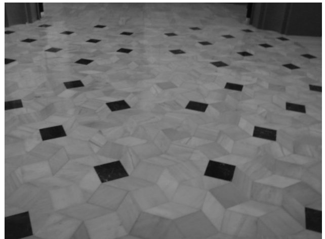
Figura 14. Nuevo suelo de la capilla de la Comunión. Foto FTP
