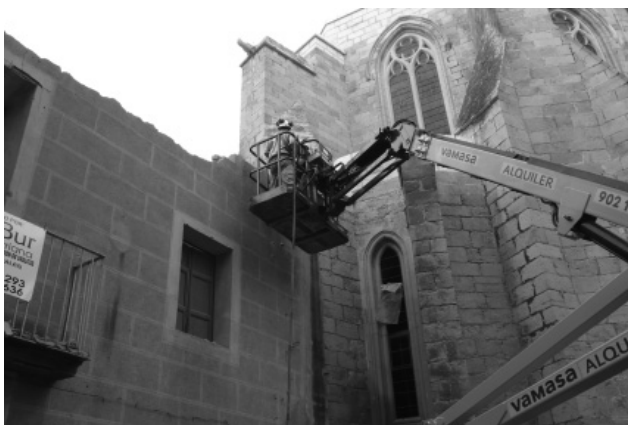
Figura 2. Derribo de la Casa Abadía. 28 de Abril de 2008. Foto FTP
