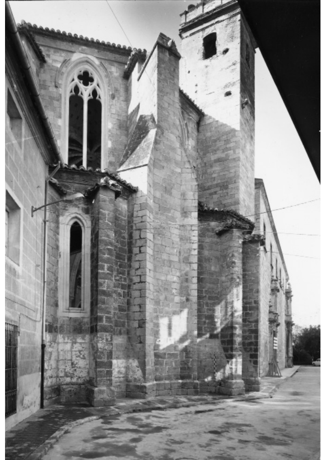
Figura 6. Abside. Vista exterior en la que se advierte la recuperación de los huecos ojivales realizada por Ferrant. Foto F. Ribera Colomer. 1969
