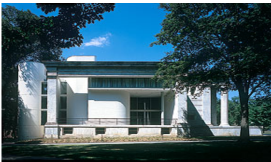
Fachada lateral del Whing Hall, Princeton University, Princeton, New Jersey, 1971, de los arquitectos Charles Gwathway & Robert Siegel
