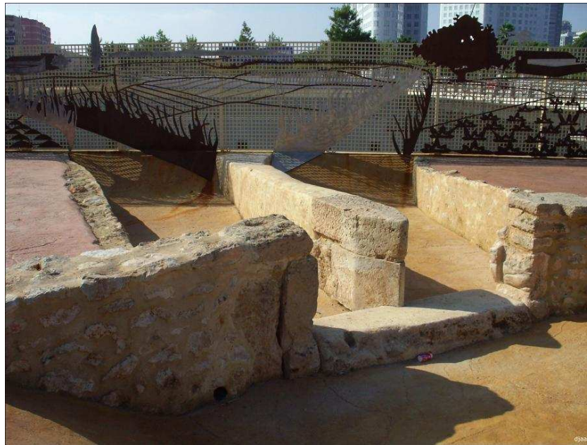
Partidor de aguas rehabilitado
