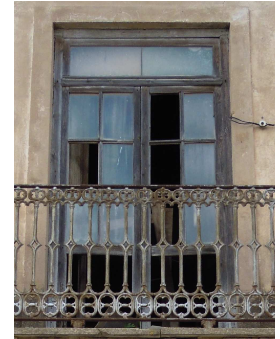
Barandilla y Puerta Balconera. Vista Exterior
