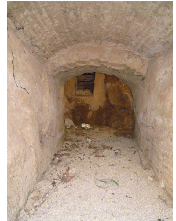
Cárcavo rehabilitado del Molino del Tell
