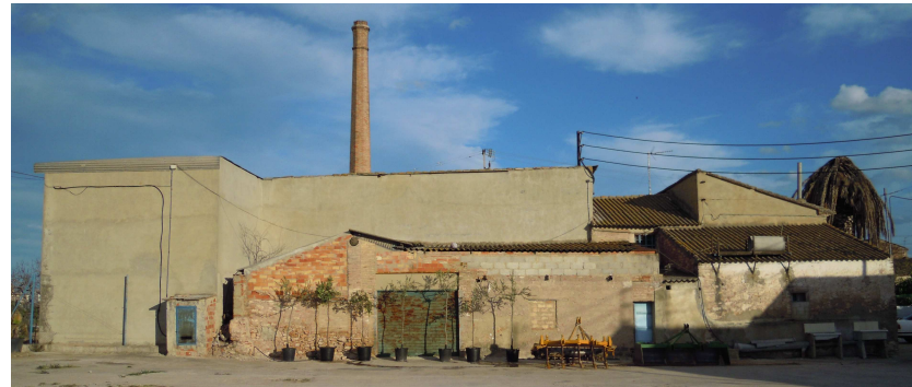
El conjunto Molino de Llobera fachada Oeste
