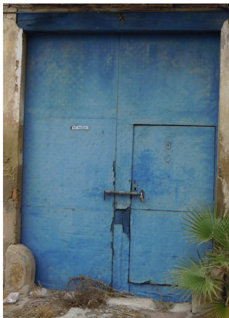
Portón con puerta de acceso a la Casa. Vista Exterior
