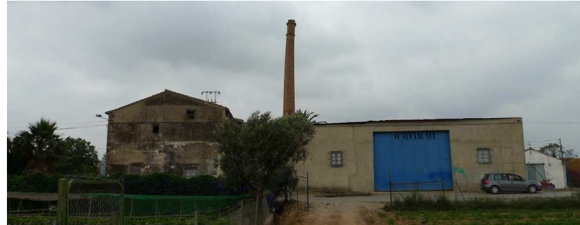
El conjunto Molino de Llobera fachada Norte
