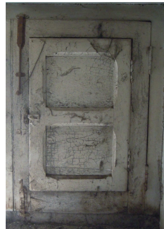
Ventana de Dormitorio 2. Vista Interior
