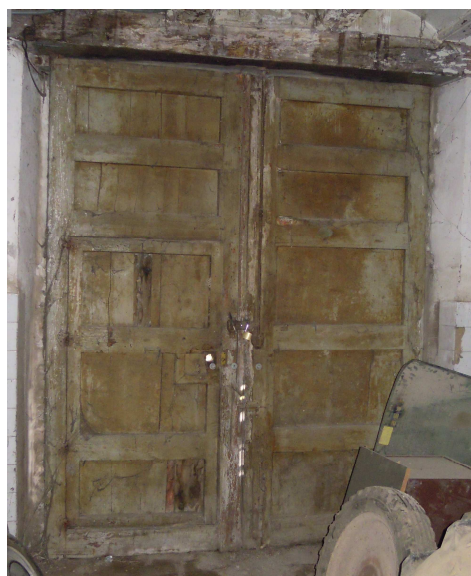
Portón con puerta de acceso a la Casa. Vista Interior
