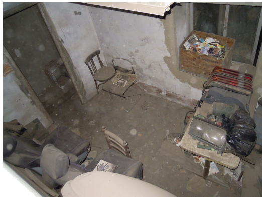
Vista de pequeña oficina de naves contiguas
