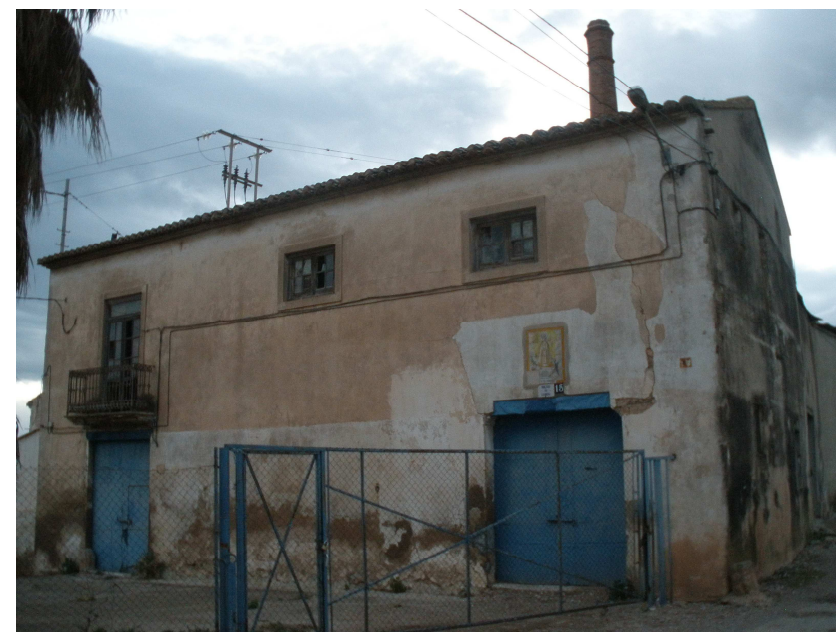
Fachada principal del Molino de Llobera
