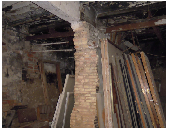
Vista de refuerzo con machones de ladrillo
