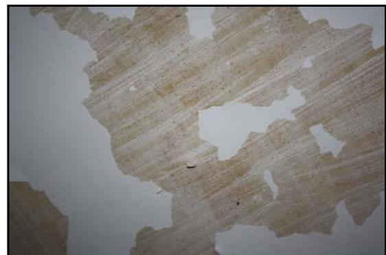
*Detalle humedad por penetración en primer forjado
