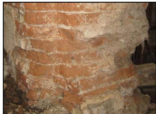
*Detalle Erosión en Pilar.*
