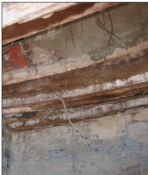
*Flecha en viga en forjado planta primera del edificio de Zona de Trabajo.*
