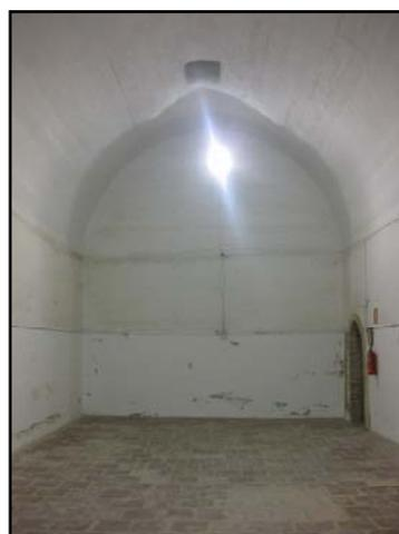
*Cisterna Árabe. Se abastecía de agua del brazo del Molí. Se aprecia la Bóveda de ladrillo encalada y la apertura superior para la extracción del agua por cubo. Catalogado como BIC.*
