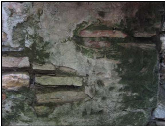
*Moho en juntas de mortero de cemento.*
