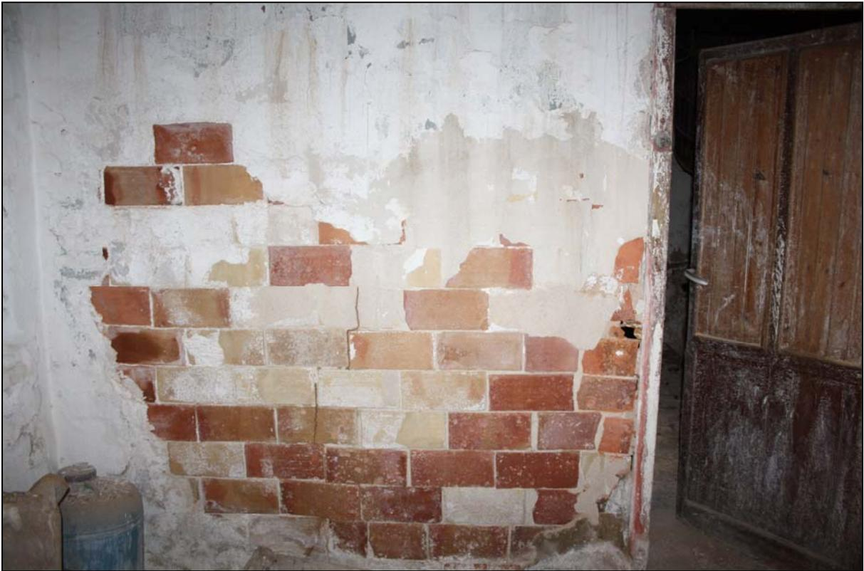
*Tabique de ladrillo, construcción con ladrillo macizo de poco grosor dispuesto a panderete de espesor 4 cm, recibido con pasta de yeso. Localizado en el edificio de Zona de Trabajo.*
