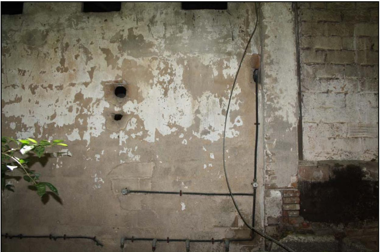
*Estructura de pilares macizos y fábrica de ladrillo con aparejo de Pandereite en edificio Silo.*
