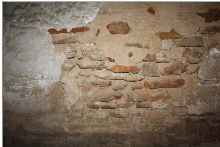
*Fotografías de ejemplo de muro mixto en edificio de Zona de Trabajo.*
