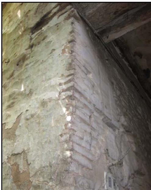
*Erosión del material en esquina del material y juntas en Edificio Zona de Trabajo.*
