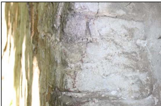
*Detalle Erosión en Pilar.*
