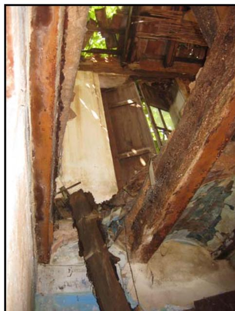
*Pudrición estructura y cubierta edificio Zona de Trabajo.*
