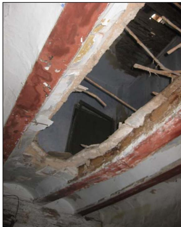
*Flecha en viga en forjado planta primera del edificio Silo.*
