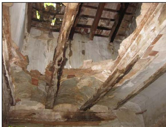
*Flecha en viga en forjado planta primera del edificio de Zona de Trabajo.*
