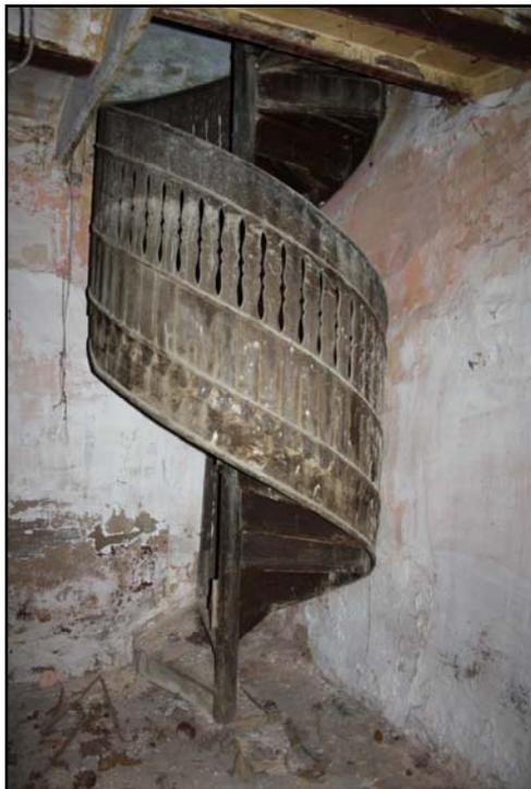
Escalera de caracol de madera de 139 cm de diámetro. Con estructura en forjado dispuesta para abrir el hueco. Localizada en el edificio de Zona de Trabajo. Continúa con descanso en la zona de desembarque en la planta superior. Peldaños realizados por medio de una superposición de piezas que nacen del eje central o núcleo. Contrahuella de 17 cm y huella en su zona media de 21 cm. Barandilla de madera con ornamento en el orden del peldaño de 60 cm.
