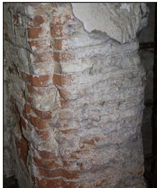
*Erosión del material en pilar en Edificio Zona de Trabajo.*
