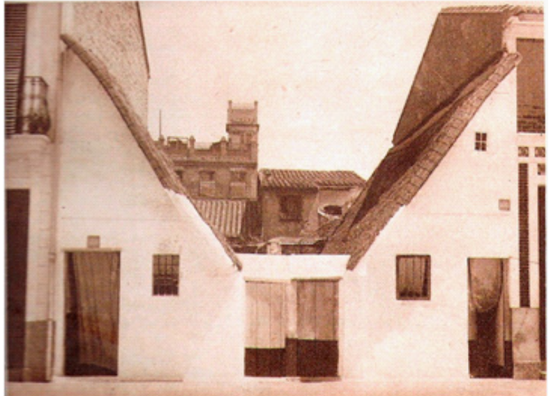
Dues mitges barraques en la transició a cases d'obra de fàbrica
