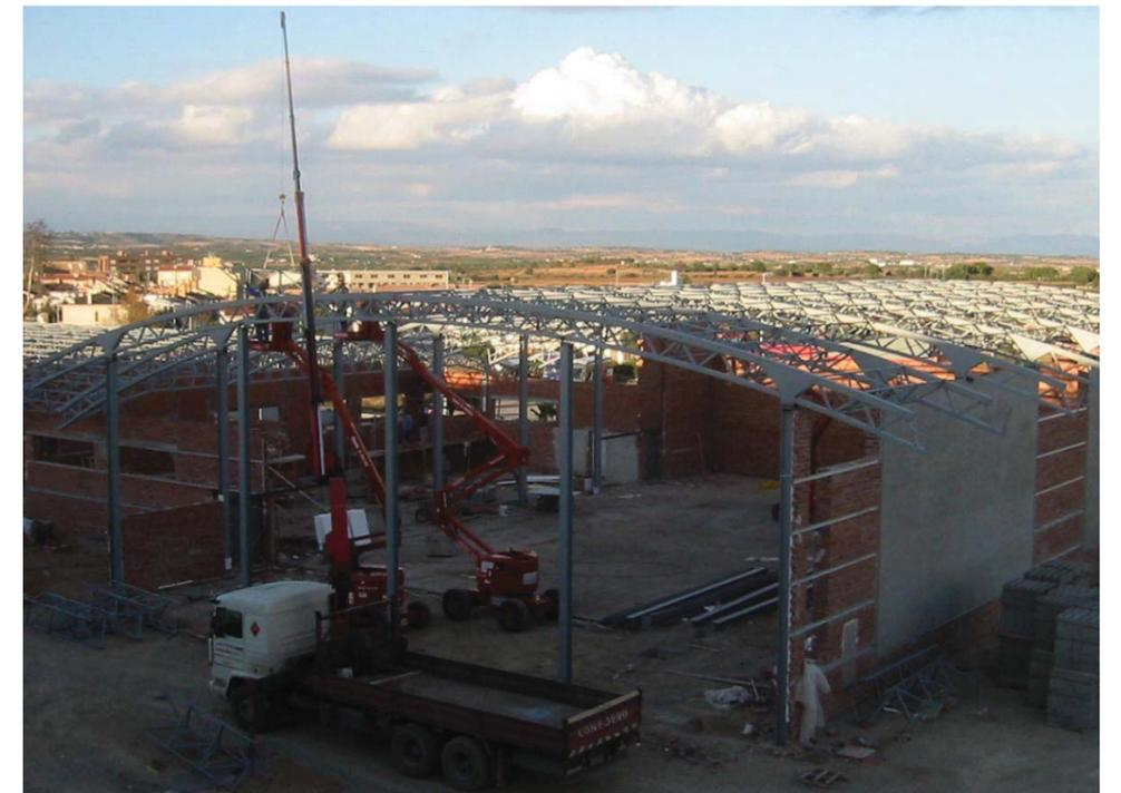
Figura 58. Vista del montaje de la estructura del Pabellón, donde podemos observar el camión grúa y las plataformas elevadoras utilizadas en la obra.
