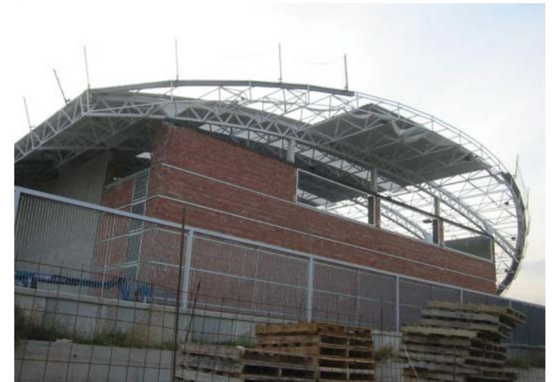
Figura 65. Vista de la fase de colocación de la cubierta.
