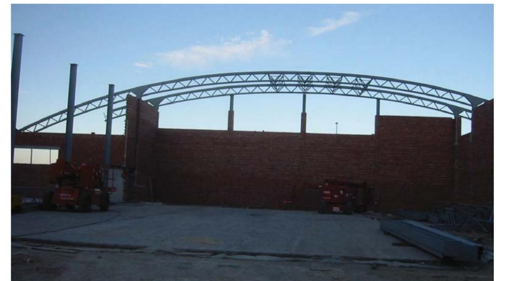
Figura 57. Vista real de la colocación de las cerchas. Podemos observar las dos plataformas elevadoras que utilizaron.
