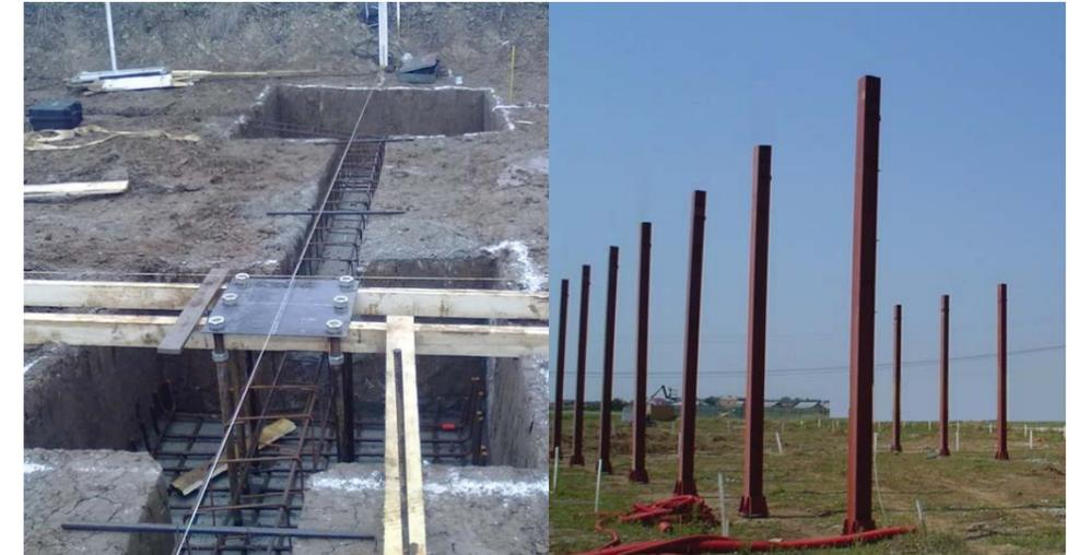
Figura 56. Vista real de una cimentación (izquierda) con placas de anclaje y posterior colocación de pilares (derecha). No son fotos que corresponden al Pabellón, ya que no disponíamos de material de estas fases constructivas, hemos considerado unas similares a modo ilustrativo.
