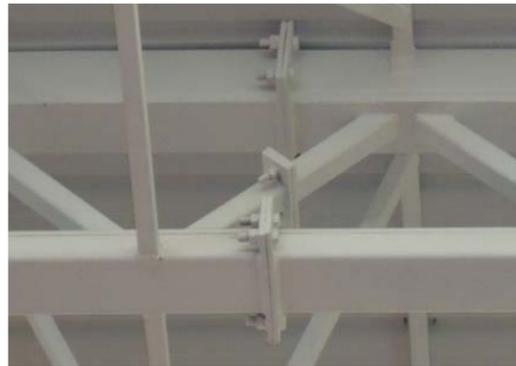
Figura 52. Foto del encuentro entre las dos partes de la cercha.
