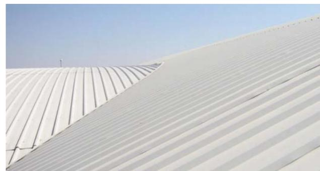
Figura 50. Limahoya de la cubierta en donde se situa la canal que recoge las aguas de la cubierta.
