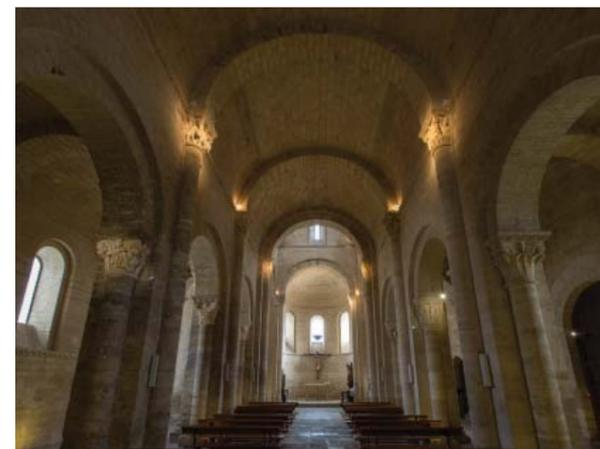
Figura 21. Vista interior, donde se aprecia la bóveda de cañón de la nave central con refuerzos de arcos fajones.
