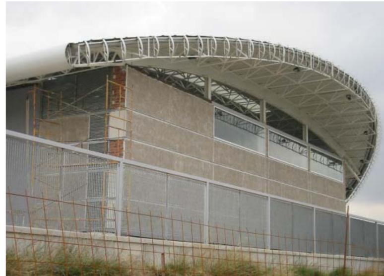
Figura 67. Vista de la fase de colocación de la cubierta.
