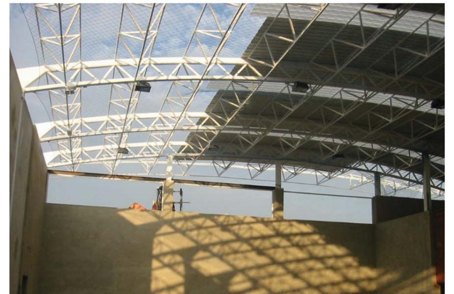
Figura 59. Vista de la fase de colocación de cubierta metálica.
