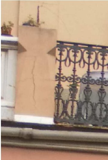
Cara exterior pilastra
