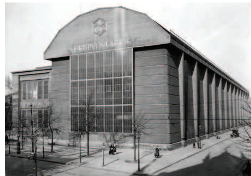
Turbinas AEG Gropius
