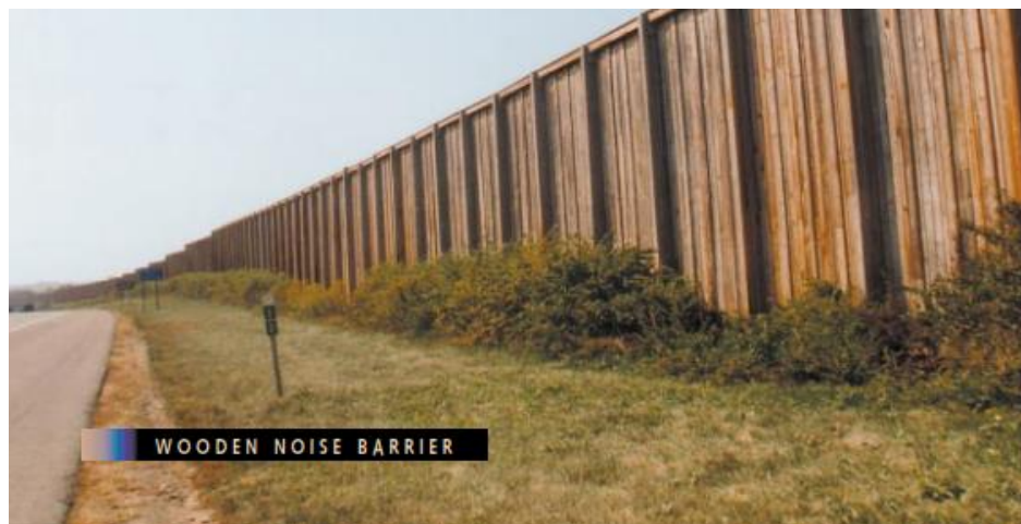
Fig. 28.- Pantalla acústica de madera (Fuente: FHWA U.S.A, 2011 [17] )
