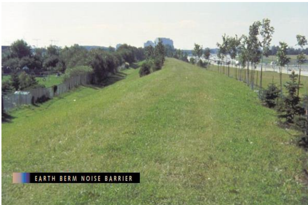
Fig. 26.- Pantalla acústica de tierra con cubierta vegetal
