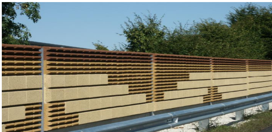
Fig. 32.- Pantalla acústica mixta hormigón poroso-ladrillo
