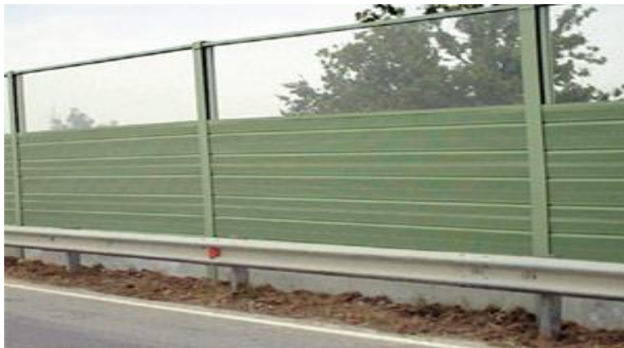
Fig. 31.- Pantalla acústica mixta metal perforado-metacrilato
