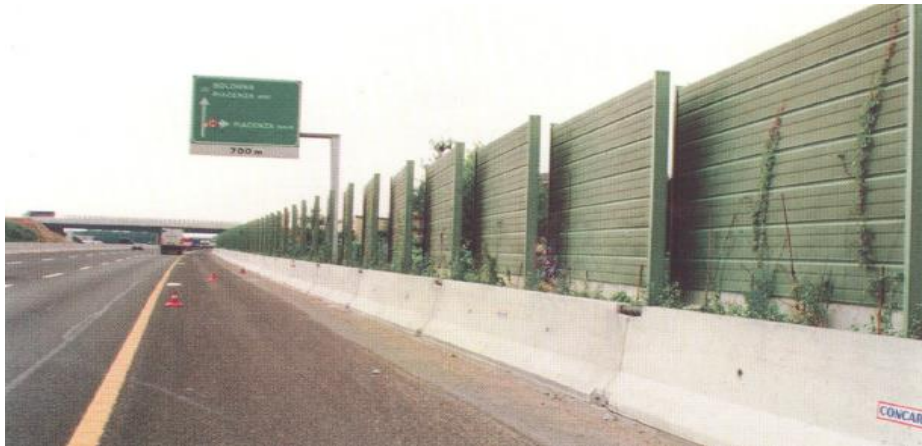
Fig. 30.- Pantalla acústica tipo “sándwich”, de metal perforado con absorbente en el interior
