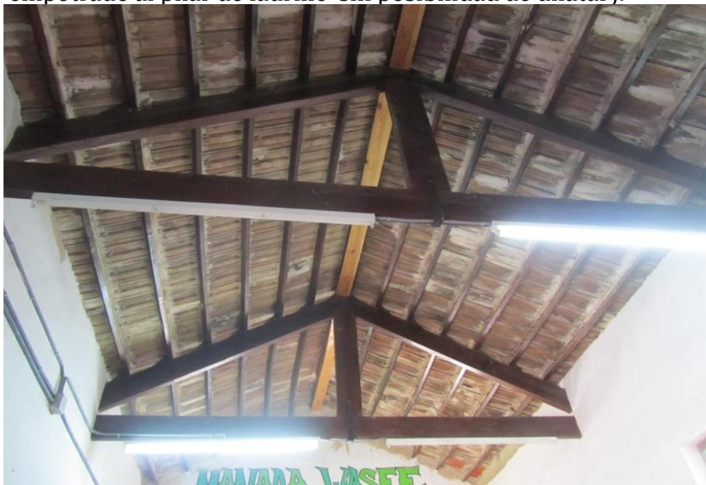
DETALLE DE CERCHA SIMPLE DE MADERA CON TIRANTE Y PENDOLON
