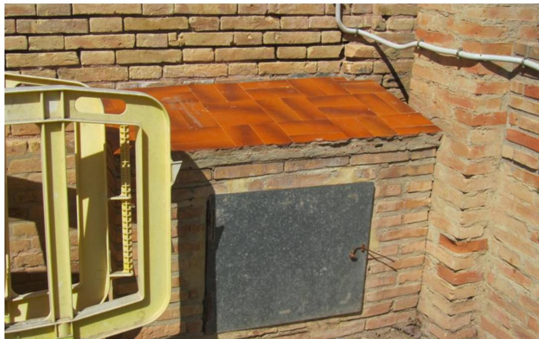
INSTALACIONES ADOSADAS A FACHADA Y DISGREGACIÓN DEL MORTERO DE LAS JUNTAS
