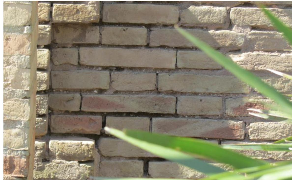
DISGREGACIÓN DEL MORTERO DEBIDO A LA HUMEDAD DE CAPILARIDAD
