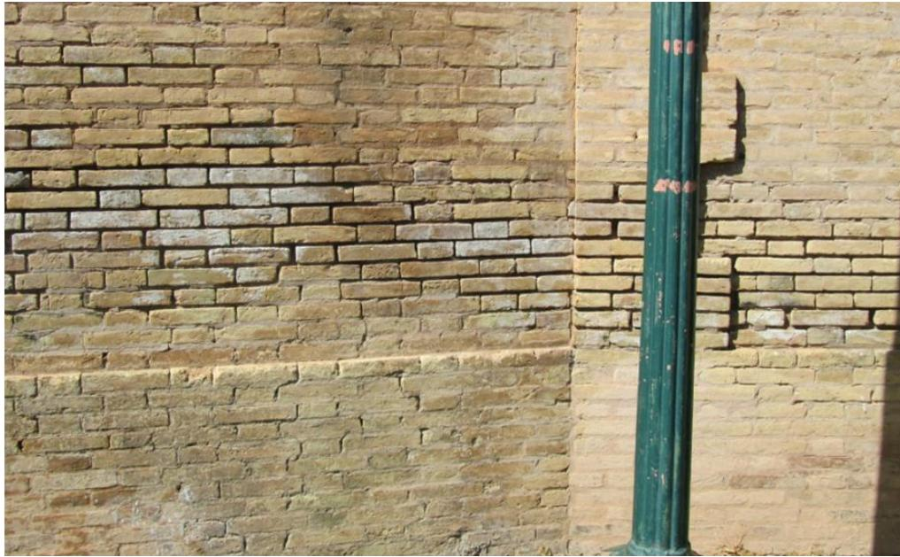
HUMEDADES DE ABSORCIÓN CAPILAR Y DISGREGACIÓN DEL MORTERO DE LAS JUNTAS CON EFLORESCENCIAS Y CALICHES EN EL LADRILLO.
