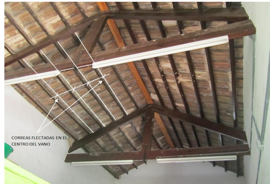
DETALLE DE CERCHA SIMPLE DE MADERA CON TIRANTE Y PENDOLON (Teja simple de encaje clavada sobre correas de madera)
