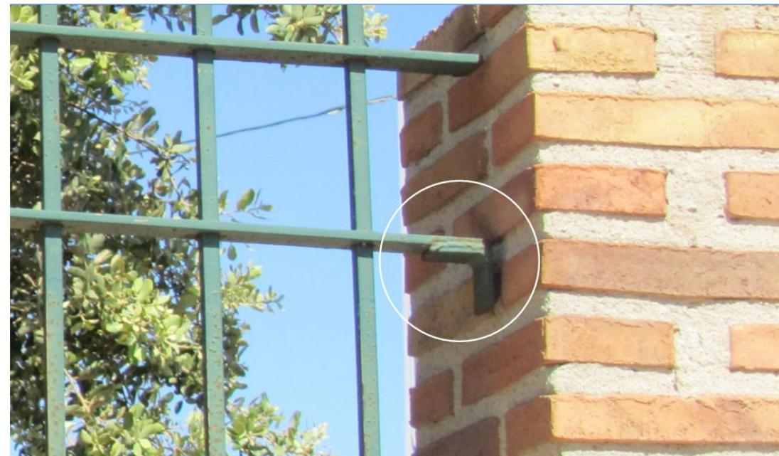
EMPOTRAMIENTO DE ANGULAR EN PILAR Y SOLDADURA DE VERJA EN VEZ DE ARTICULACIÓN CON LA MISMA MEDIANTE AGUJERO COLISO Y PASADOR ATORNILLADO.
