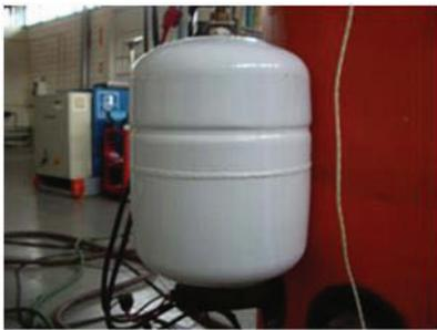
Fig. 4.4 Vaso de expansión del CAC.
