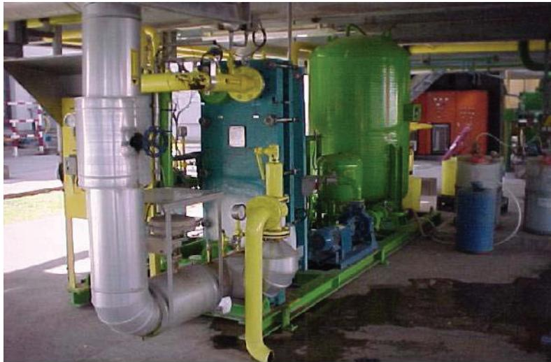
Fig. C.1 Planta de subenfriamiento del refrigerante y vaporización de CO<sub>2</sub> en una industria de la alimentación
