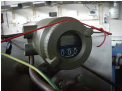
Fig. 4.16 Caudalímetro electromagnético del CDC
