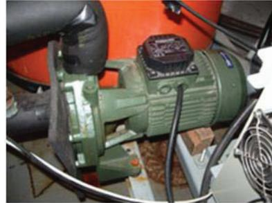
Fig. 4.7 Bomba de empuje del CAC.
