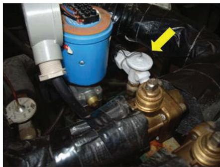
Fig. 4.24 Válvula de expansión termostática.
