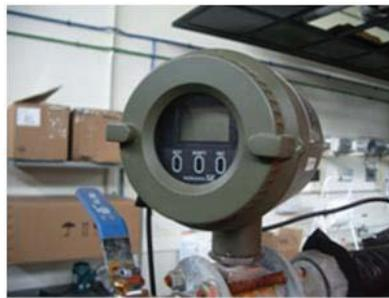
Fig. 4.5 Caudalímetro electromagnético del CAC.
