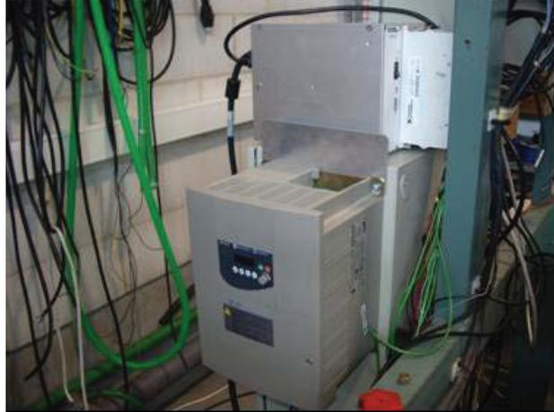
Fig. 4.32 Variador de frecuencia ALTIVAR28.
