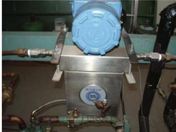
Fig. 4.29 Caudalímetro másico
