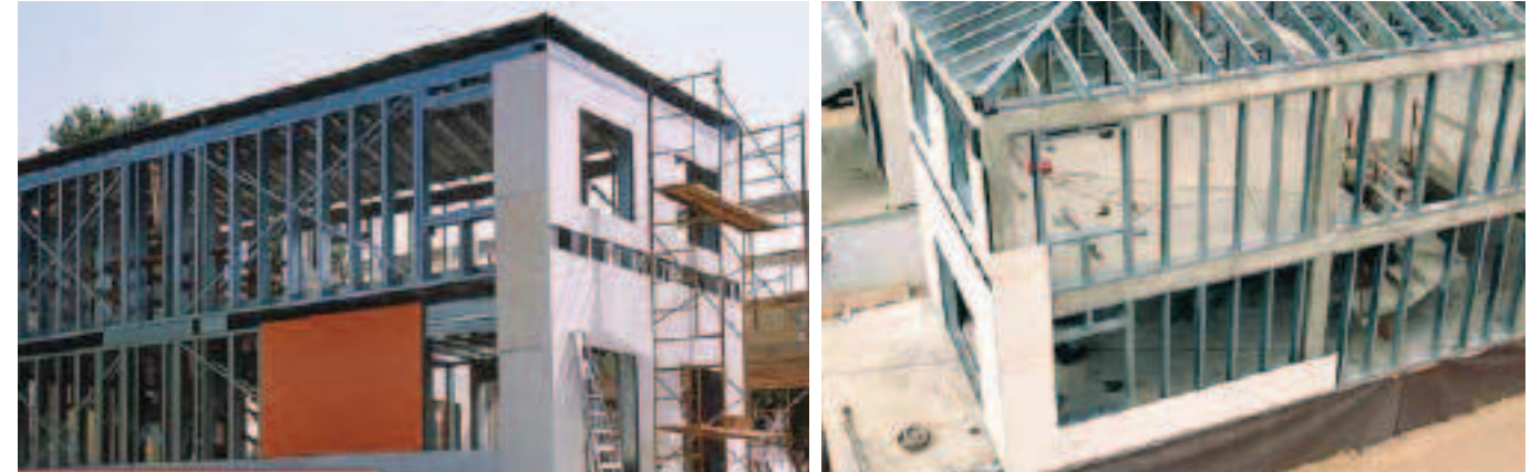
Dos unifamiliares en Begues, una de estructura ligera y otra de estructura de hormigón con subestructura ligera. Paneles grandes con junta sellada.
