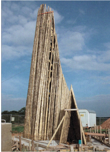
Peter Zumthor, Capilla Bruder Klaus , Mechernich, Alemania, 2007, Imágenes proceso encofrado.
