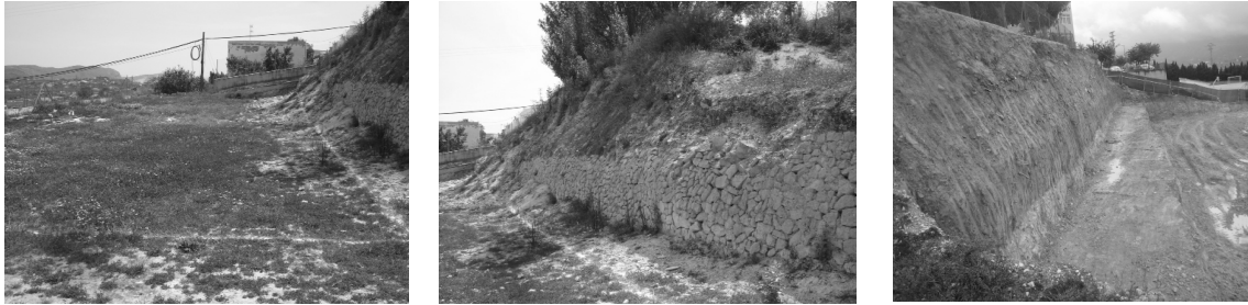
Gimnasio en Bennisà (2005-2009) | proyecto obra | hormigón, acero, aluminio, vidrio, acabados enfosado blanco, caucho sintético. | dim. parcela : 40 x 15 m; sala gimnasio 16 x 6 x 5'5m . Vestuarios y otros; dimensiones variables x 3 m altura.
