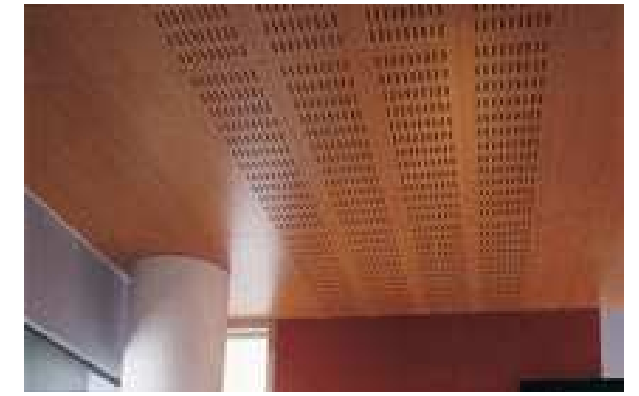
Corredor. Falso techo paneles de madera.
