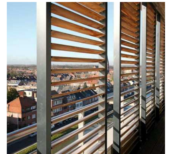
Paneles de lamas de madera de la casa Colt. Control solar.
