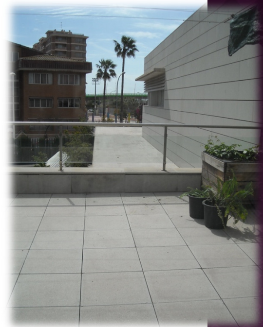
Terraza de pavimento flotante
