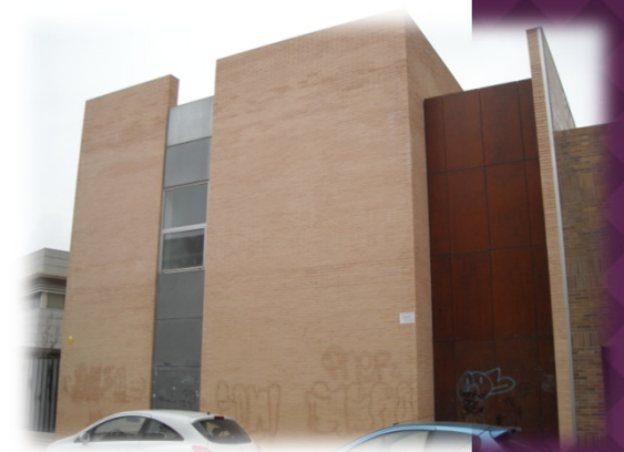
Fachada ladrillo visto y panel madera C/ Colón
