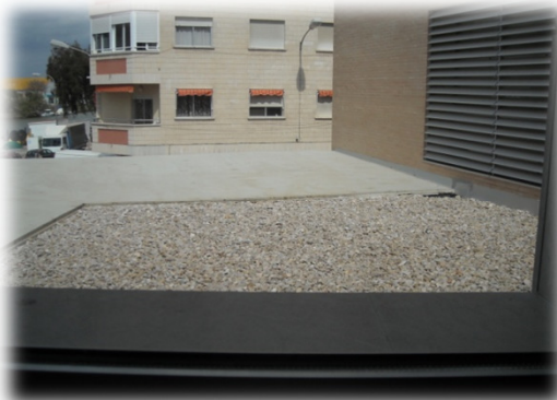
Cubierta invertida entrada centro ocupacional
