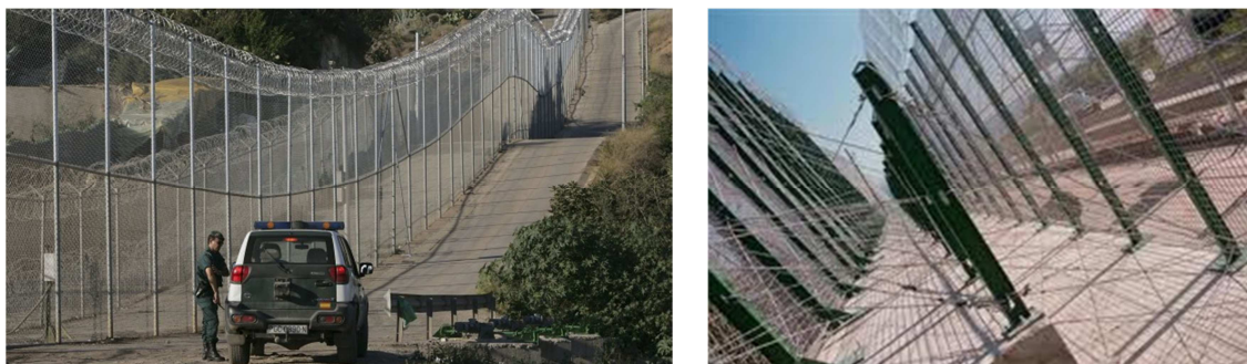
Vista de la tanca de Melilla amb la carretera interna per a facilitar la vigilància amb vehicles a motor. A la dreta, detall de l'anomenat "cablejat de detecció tridimensional en l'espai intermedi".
