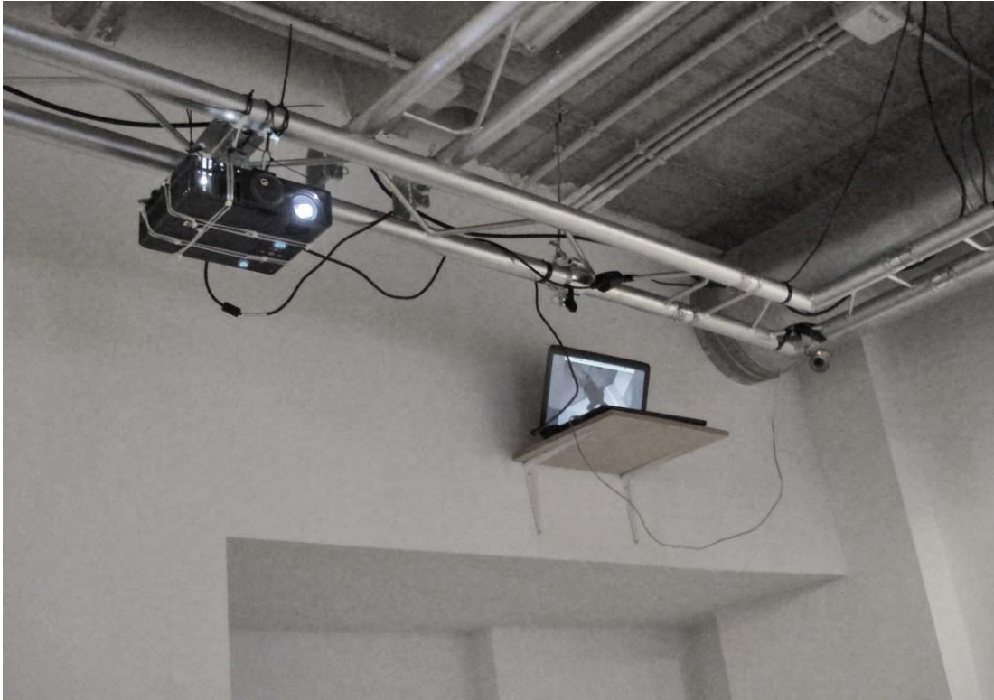
Fig.21. Vista de la instalación Animales localizados , 2011
