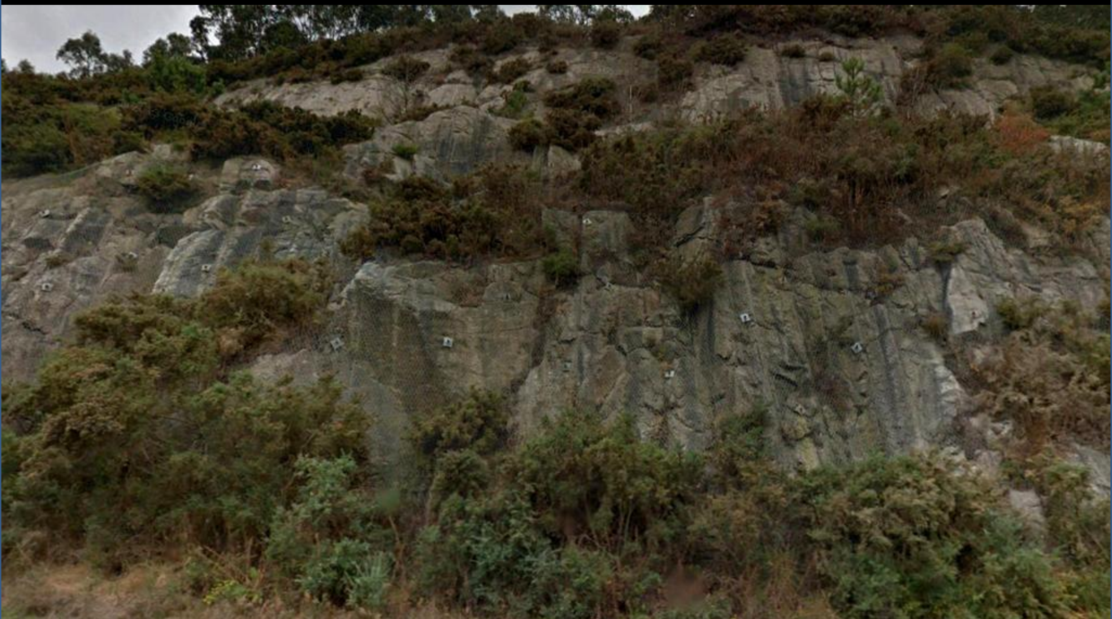
Granitos de grano grueso con mallazo y bulonado. S de la Playa de Marosa, NW de Vilar, SW Hoja de San Ciprian, Lugo.
