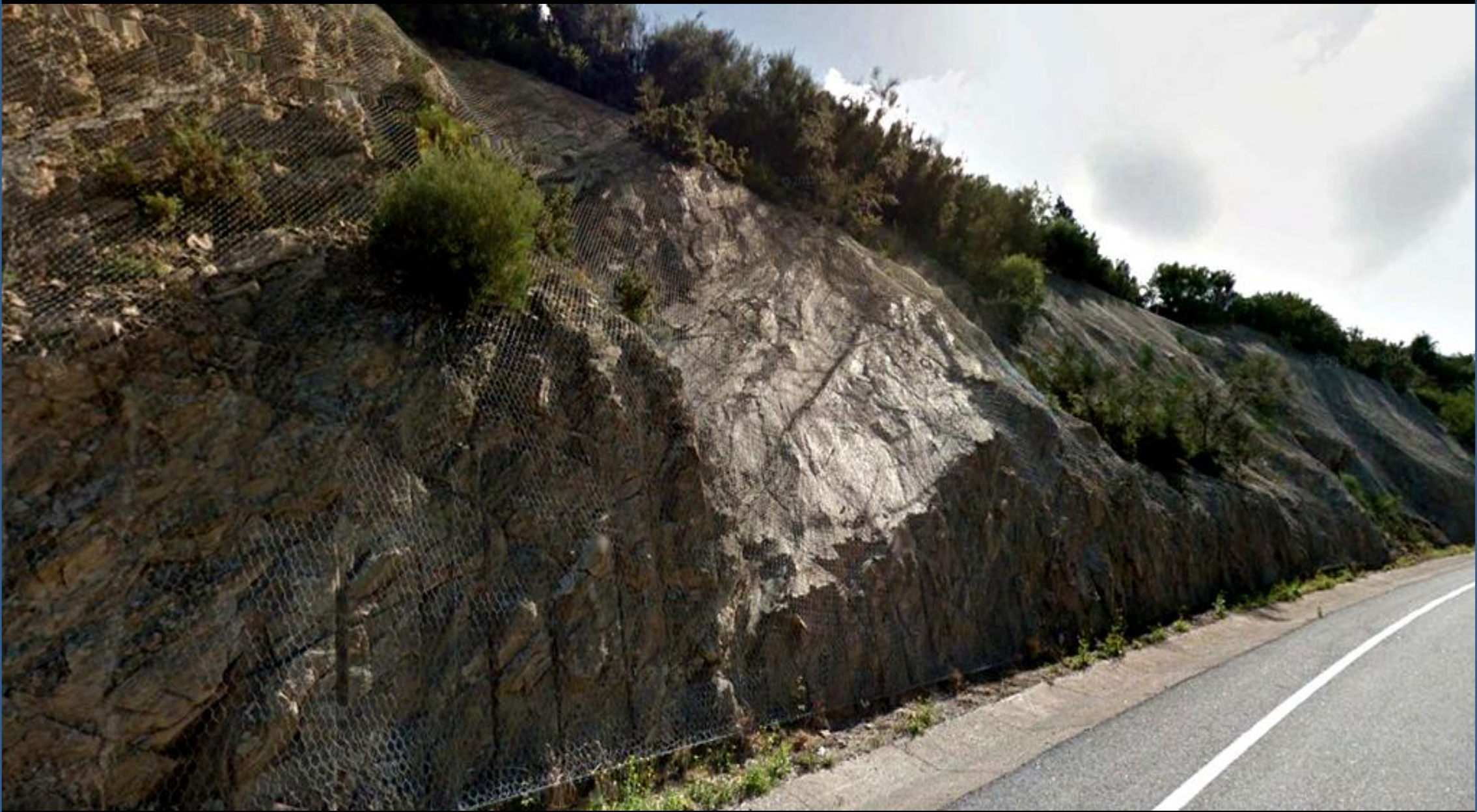
Mallazo sobre los granitos de dos micas con plano de falla. N de Fraga, Lugo. SE Hoja de Vivero.
