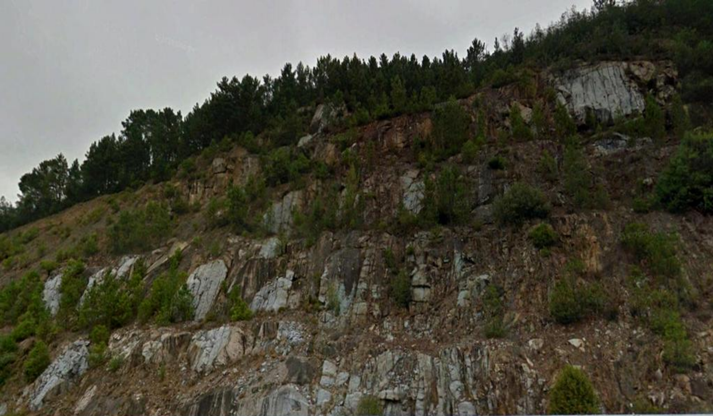
Talud de granodioritas de biotita. A52, W de Razamonde, Orense. N Centro E Hoja de Ribadavia.
