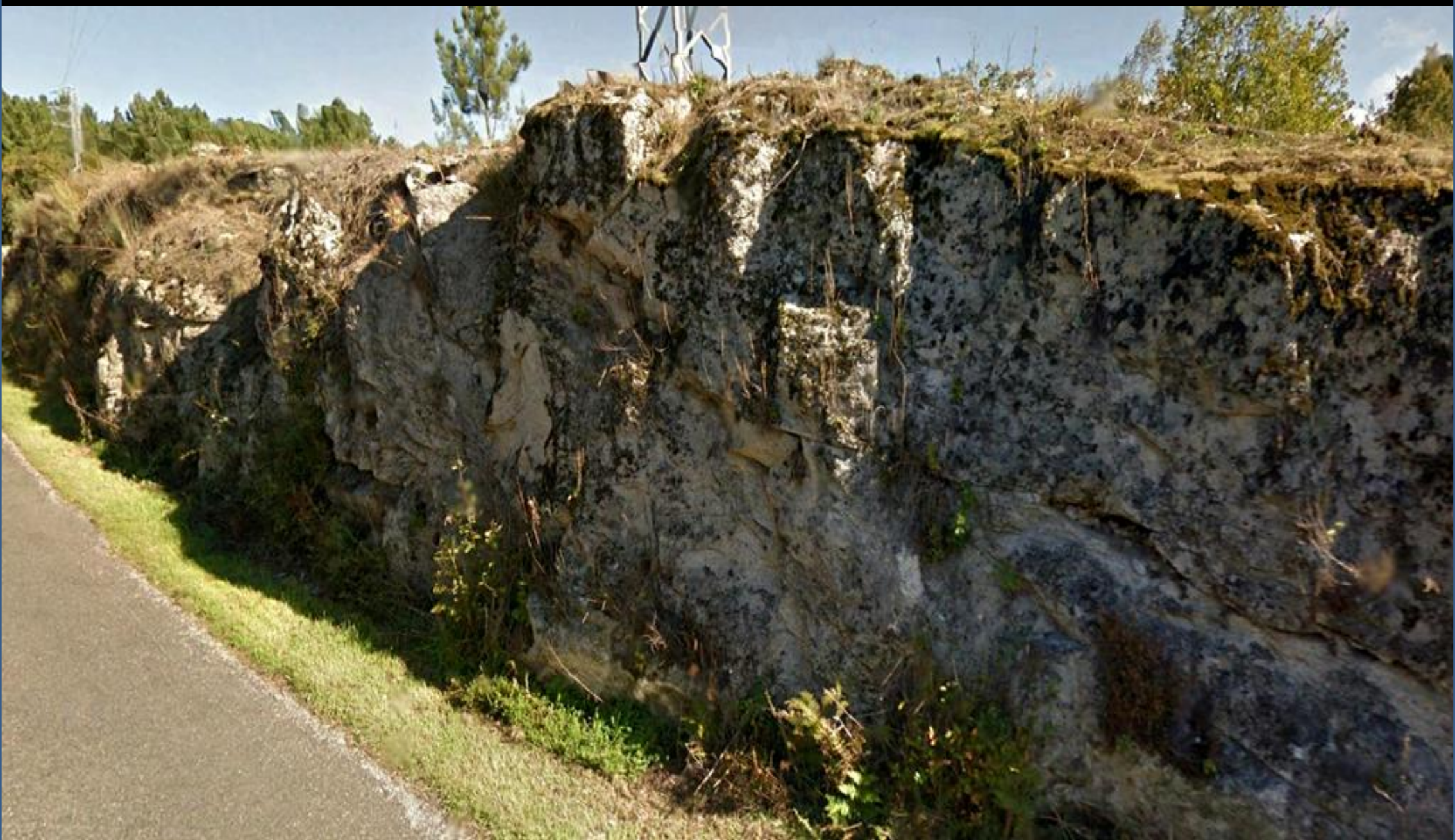
Erosión de granitos de grano grueso. En el E de San Xoan de Moreiras, Orense. NW Hoja de Allariz.
