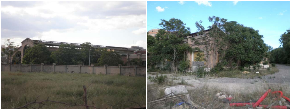
Imagen 39 y 40 Nave Industrial de Demetrio Ribes, vista desde el camino de conexión entre Malilla y calle Filipinas
