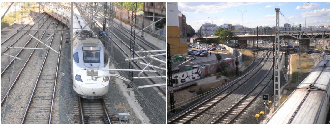
Imagen 17 y 18 Paso del tren bajo la pasarela y el puente de Giorgeta
