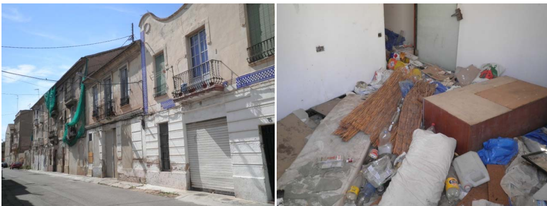
Imagen 5 y 6 Una zona olvidada hace tiempo. No existe mantenimiento.
