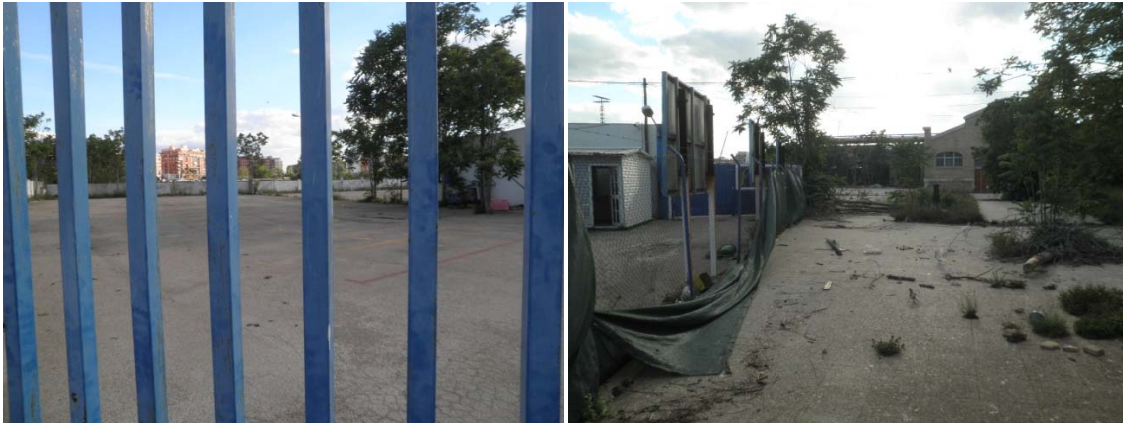
Imagen 31 y 32 Diversas zonas en calle Filipinas en abandono
