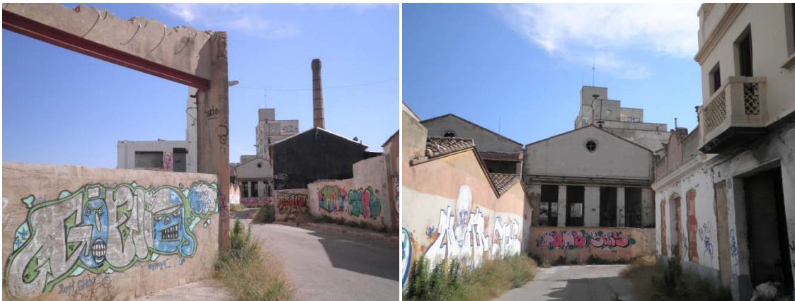
Imagen 3 y 4 La zona de San Vicente posee varia edificaciones en ruinas también alguna se encuentra ocupada
