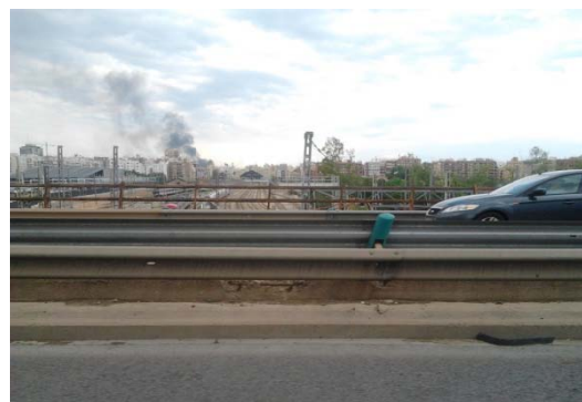
Figura 2 Elaboración propia (RP) Puente Iturbi – transito, hacia estación del Norte
