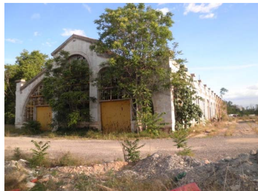
Figura 5 (RP) Nave proyectada por el Arquitecto Demetrio Ribas, situadas junto a las Naves Le eras
