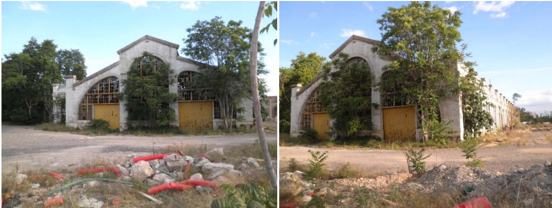
Imagen 37 y 38 Nave Industrial abandonada, de Demetrio Ribes. Restaurada en la fase 1 del Parque Central
