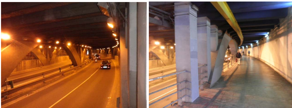
Figura 24 (RP) Túnel de conexión de las Grandes Vías (Izq.) Vista interior del paso Peatonal (Der.)
