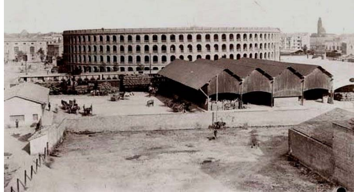
Figura 7 Foto de Archivo. Estación del Norte en construcción (1907)www.skyscrapercity.com
