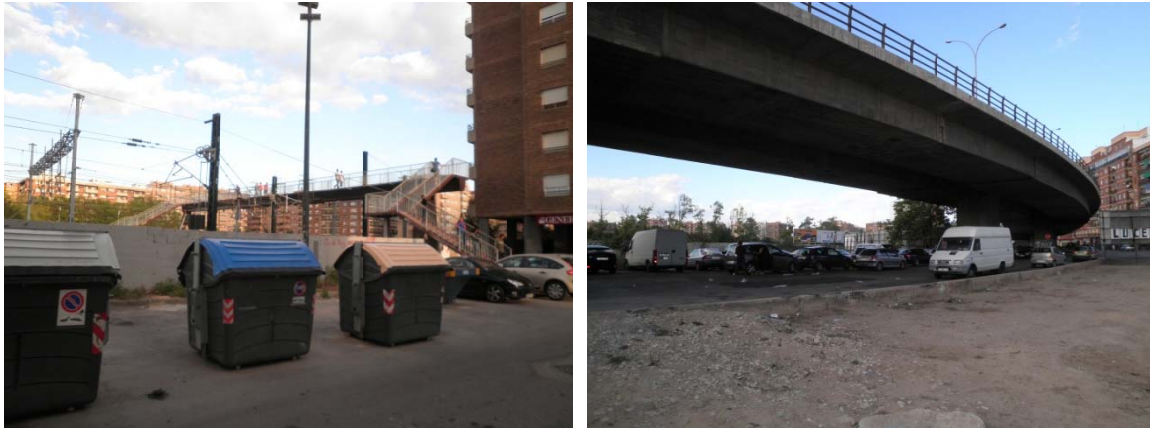
Figura 23 (RP) Pasarela desde edificio Iturbi (Izq.) Vista inferior del Puente Giorgeta o Iturbi (Der.)
