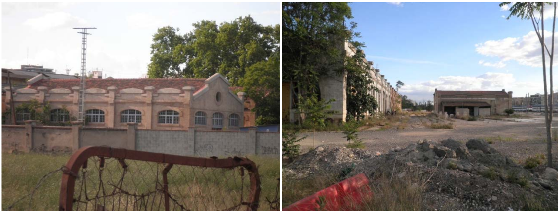
Imagen 33 y 34 Naves Leñeras, se conservaran y restauraran habilitando como equipaciones tras la realización de la fase 1
