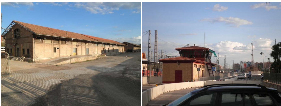
Imagen 11 y 12 Instalaciones ferroviarias, almacenaje, control de trenes...
