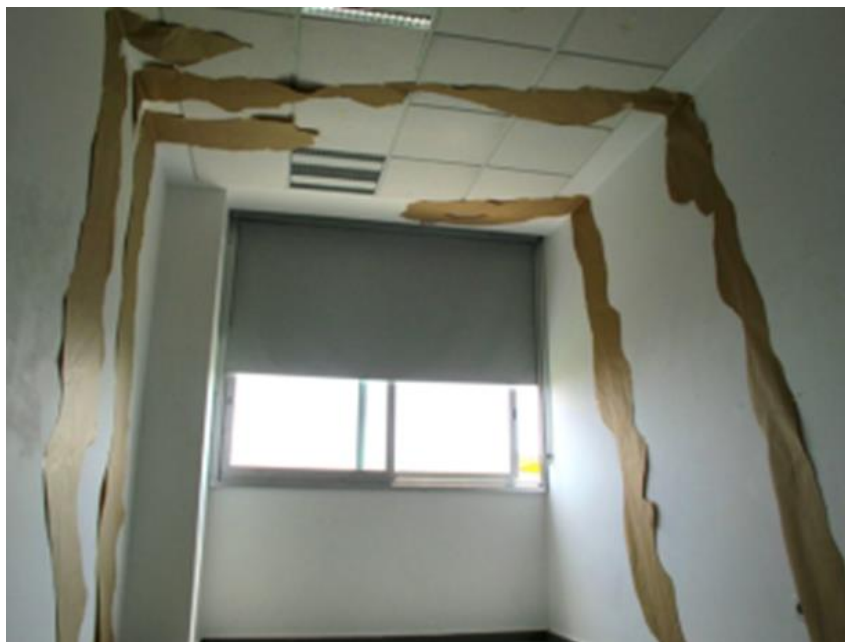
Fig.62 Intervención Project Room A-2-8
