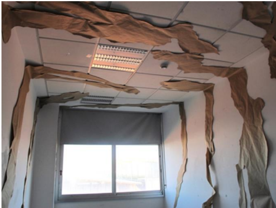
Fig.64 Intervención Project Room A-2-8
