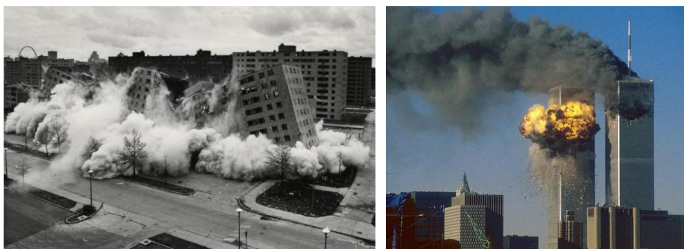
Fig. 45. Fotografía demolición de viviendas Pruitt-Igoe, 1970 / fotografía atentados World Trade Center, 2001.
