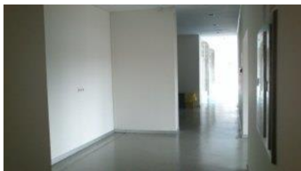
Fig. 58 Pasillos de acceso a los sótanos, los recovecos que crean las paredes son muy aprovechables para acoger estanterías con material. Fuente: la autora.
