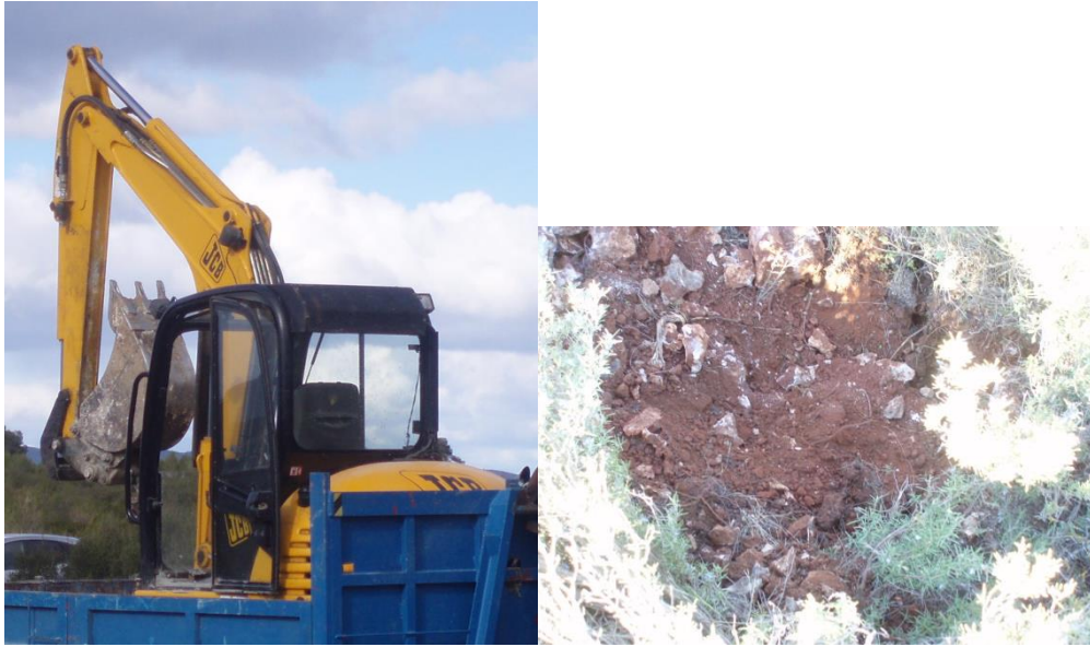
Figura 7. Detalle de la retroexcavadora (izquierda) y aspecto del terreno pedregoso (derecha)
