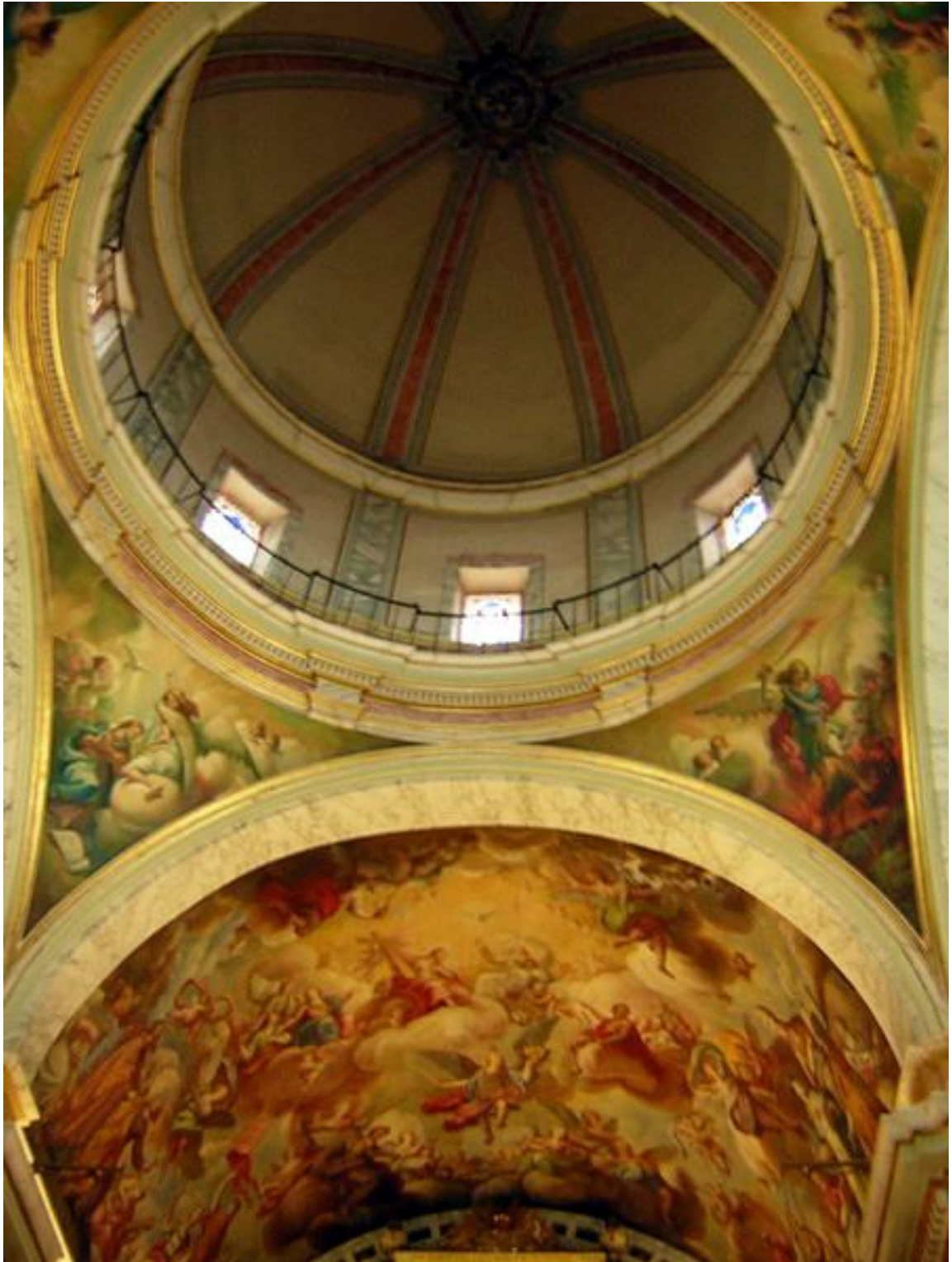
78. Bóveda de la Iglesia del Ángel. Vall de Uxó (Castelló).
