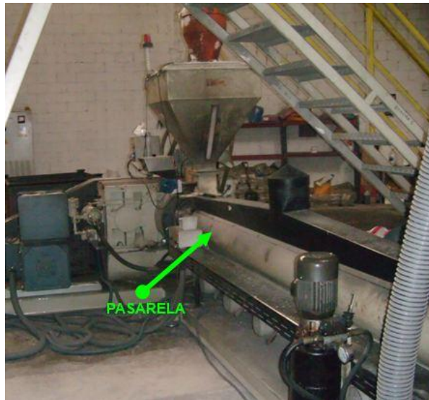
Figura 30: Pasarela por donde la materia prima se calienta y se funde
