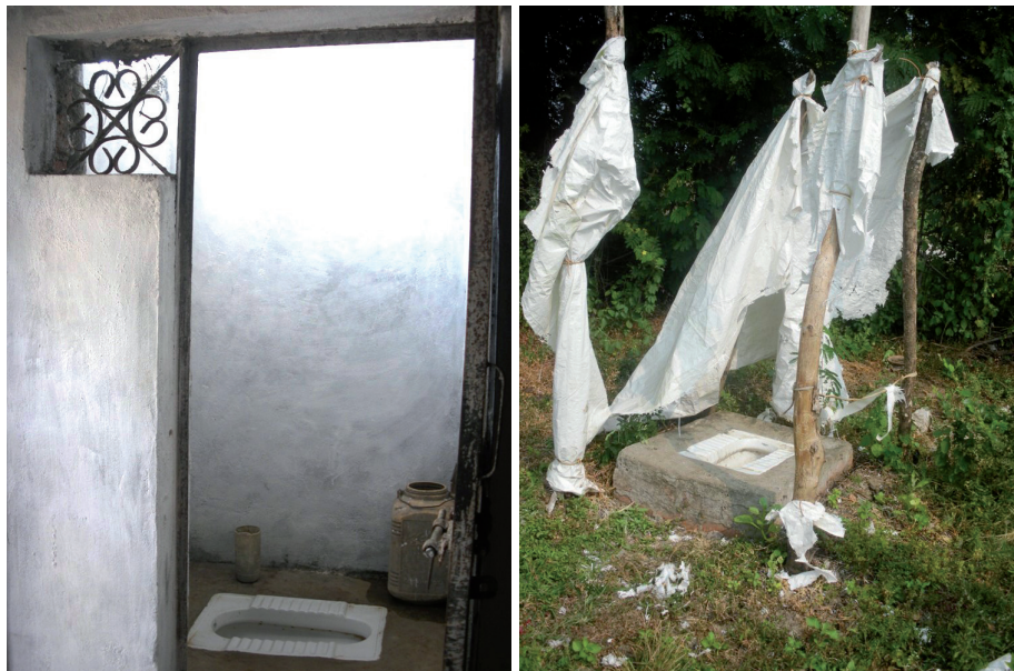
Fotografía 17: Ejemplos contrapuestos de movimientos en la escalera del saneamiento; a la izquierda, una letrina recién construida para sustituir una peor, a la derecha, una letrina con estructura temporal, recientemente dañada por una tormenta (El autor)
