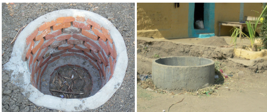
Fotografía 12: Fosa filtrante de ladrillos (izda.) y de anillos (dcha.) (El autor)
