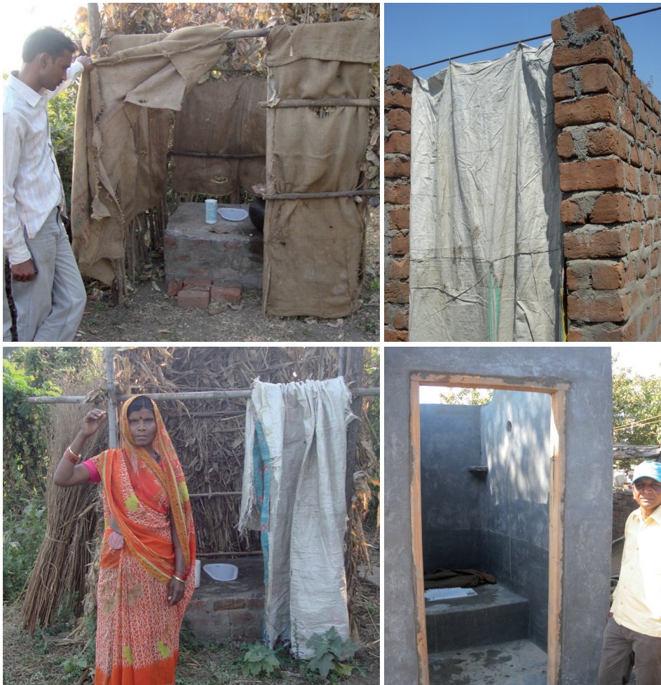
Fotografía 14: Distintos materiales utilizados para la estructura de la letrina: tela (arriba a la izda.), maderas (abajo a la izda.), ladrillo (arriba a la dcha.) y ladrillo enlucido (abajo a la dcha.) (El autor)
