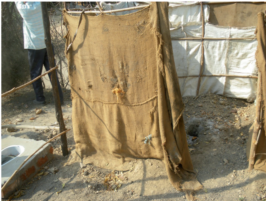
Fotografía 11: Ejemplo del avance en la escalera del saneamiento: a la derecha aparece una letrina seca construida al inicio de la campaña que se iba a dejar de utilizar y a cerrar una vez finalizada la letrina con arrastre de agua que aparece a la izquierda.
