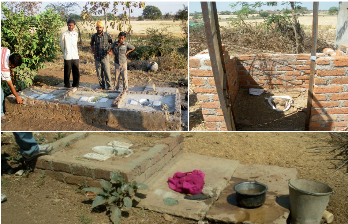
Fotografía 6: Ejemplos de la falta de apropiación y utilización de las letrinas construidas en el marco de la Total Sanitation Campaign (El autor)
