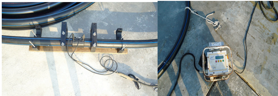
Figura 53: Soldadura por medio de aplicación de calor. Soldadora térmica.
