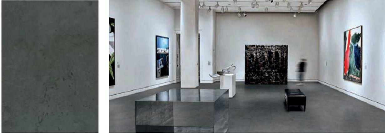
Se ha empleado para la biblioteca un pavimento linóleo gris continuo de la marca Armsrong modelo Linodur 4mm de espesor, dispuesto sobre terrado de 3cm de espesor tomado con cemento cola. Se ha escogido este material por las exigencias acústicas y atendiendo a cuestiones de confort por tratarse de un material más blando y cálido que los pétreos.
