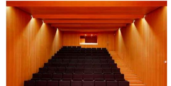
Empanelado de contrachapado lacado en blanco de dimensiones 750x20x5cm sobre una estructura tubular de acero galvanizado. En el exterior los lucernarios están resuetos mediante chapas de zinc.
