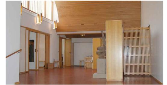
Empanelado de contrachapado lacado en blanco en sala de exposiciones (de textura de haya vaporizada en biblioteca y zona aulas) anclados sobre una estructura auxiliar de acero galvanizado de cuelgue regulable.
