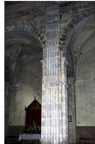
Fig VII.146: Ménsulas de apoyo en las pilastras para apoyo del coro.
