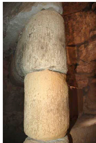
Fig VII.185: Peldaños de la escalera.
