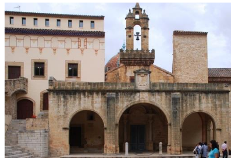
Fig V.28: Pórtico Real Santuario de la Mare de Deu. Traiguera.
