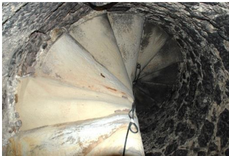
Fig VII.8: Señales de calcinación en la escalera de caracol.
