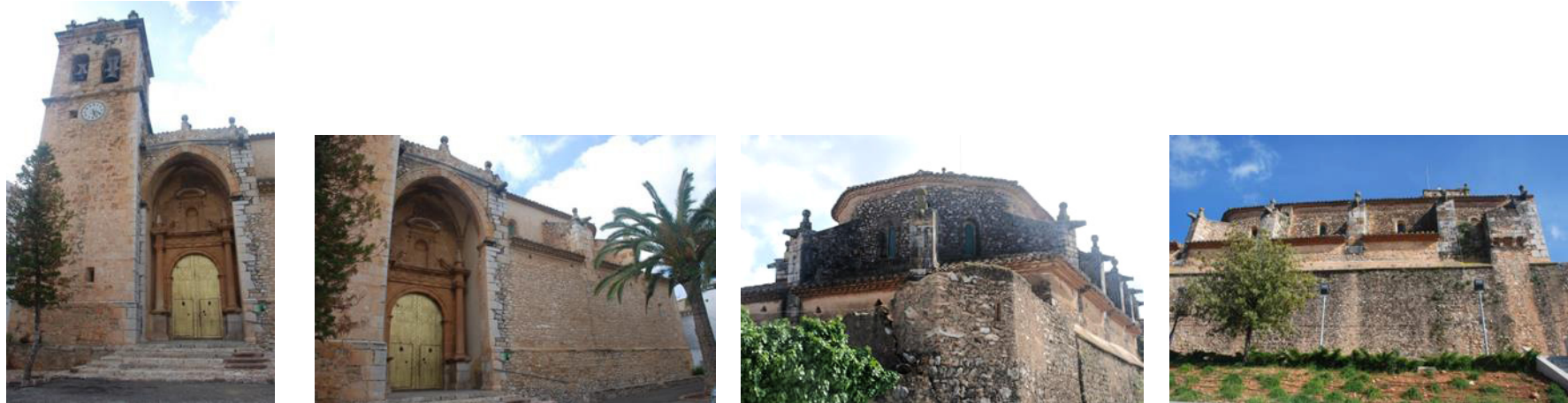
Fig VI-4: Iglesia Benlloch ( Castellón)
