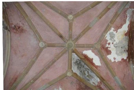
Fig VII.148: Bóveda de la sacristía.
