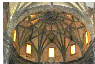
Fig VII.128: Exterior e interior de las ventanas abocinadas interiormente situadas en la fachada este.
