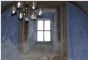
Fig VII.129: Exterior e interior de las ventanas abocinadas interiormente situadas en la fachada este.
