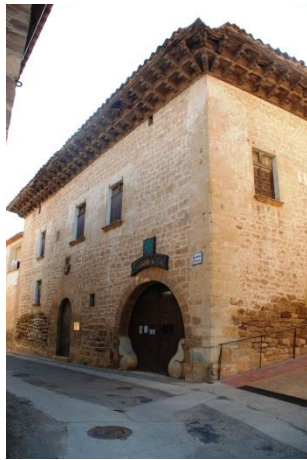
Fig V.34: Casa marqués de Figuera. Olocau.
