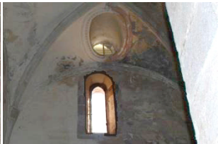
Fig VII.127: Exterior e interior de las ventanas en forma de aspillera abocinada, linterna y ventana rectangular situadas en la fachada sur.
