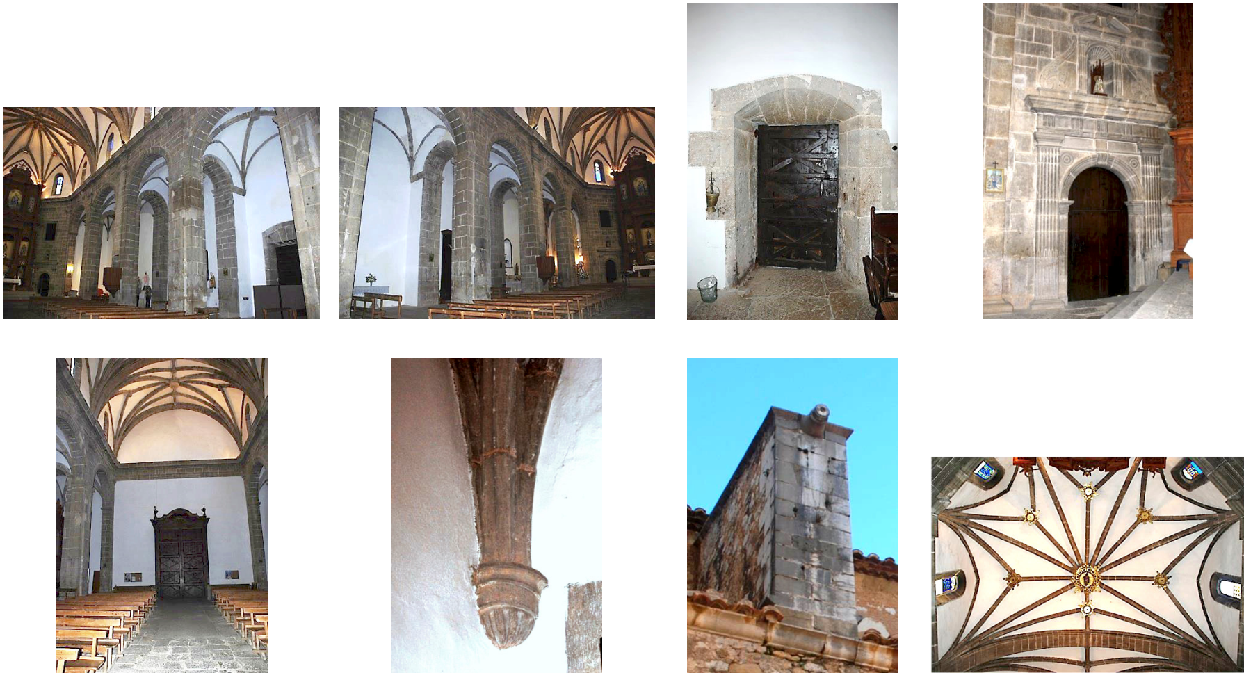
Fig VIII. 17: Detalles del edificio.
