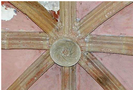
Fig VII.203: Clave central bóveda sacristía.
