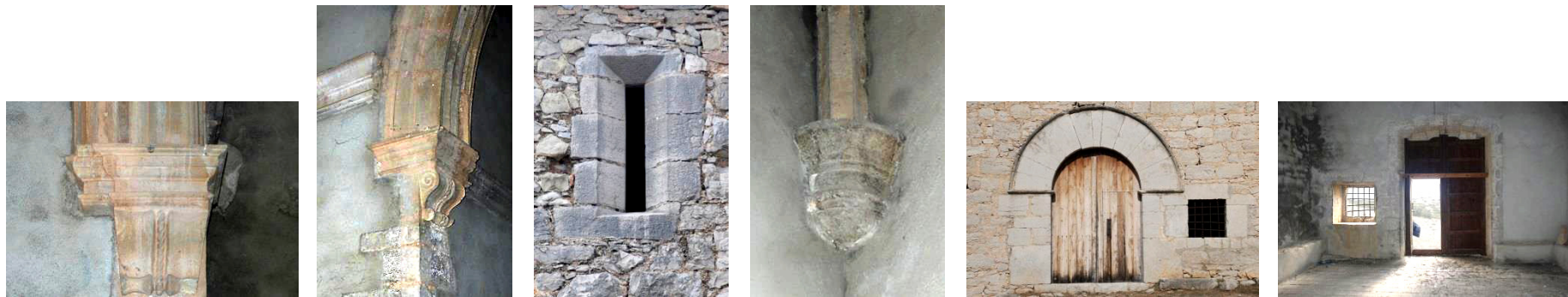
Fig VIII. 9: Detalles del edificio.
