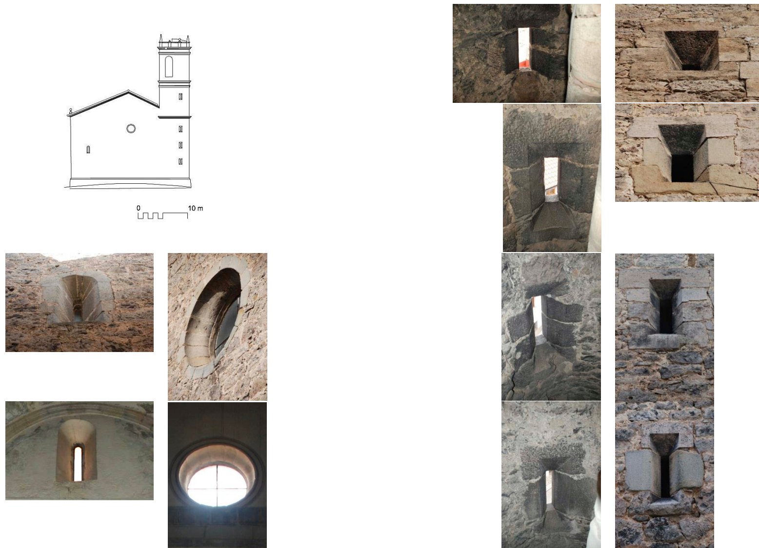
Fig VII.126: Exterior e interior de las ventanas en forma de aspillera abocinada y óculo situados en la fachada oeste.
