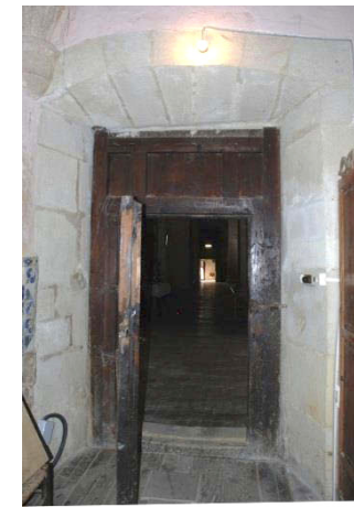
Fig VII.150: Interior puerta sacristía.
