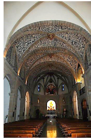
Fig V.52: Interior iglesia L'Alcora..
