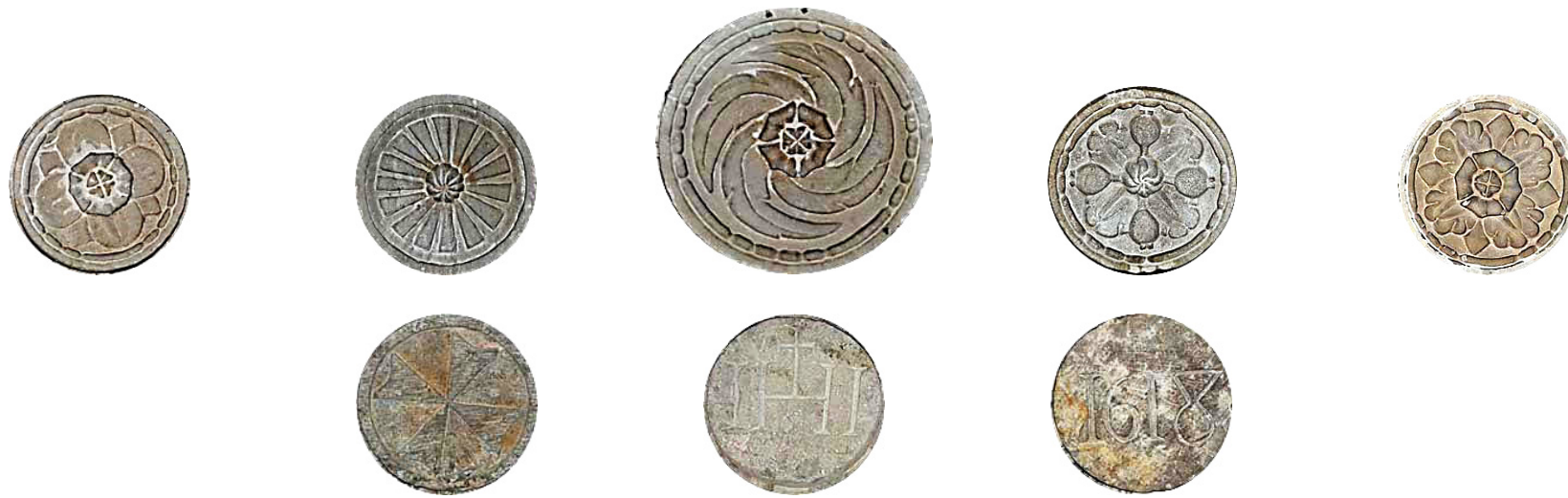
Fig VIII. 8: Claves que aparecen en la bóveda del presbiterio y en la nave principal.
