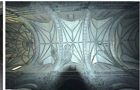
Fig VII.111: Bóvedas de la nave principal.
