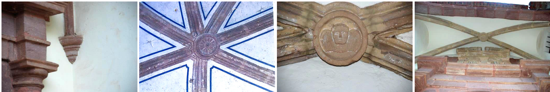
Fig VIII. 27: Detalles de la ermita de Les Santes. Cabanes. Castellón.
