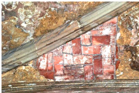
Fig VII.211: Plementería en bóveda de capilla lateral.
