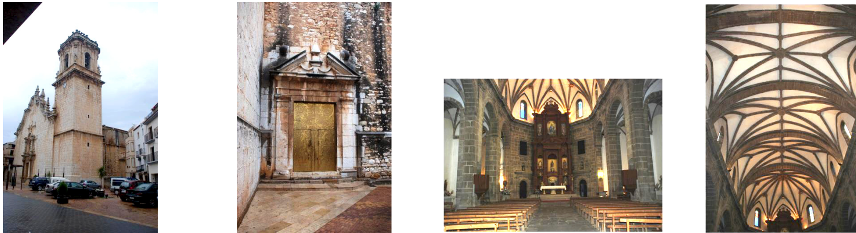
Fig VIII. 14: Exterior e interior de la iglesia de La Jana
