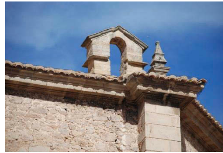
Fig VII.182: Espadaña sobre el ábside.
