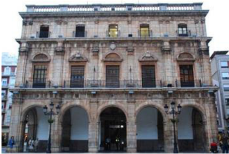
Fig V.10: Fachada Ayuntamiento Castellón
