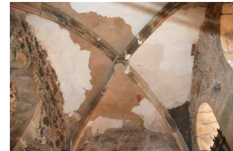
Fig VII.187: Bóveda en la sala de campanas.
