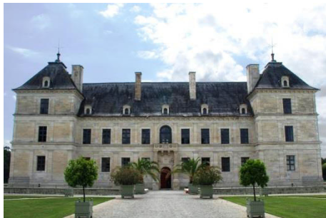
Fig V.6: Fachada principal del Castillo de Ancy-le-Franc.
