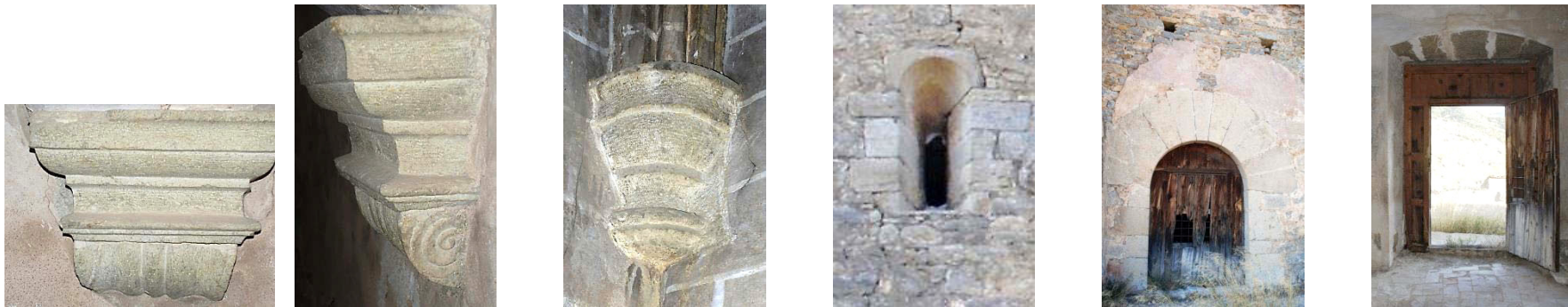
Fig VIII. 4: Detalles del edificio.
