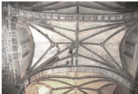
Fig VII.113: Bóveda nave principal.
