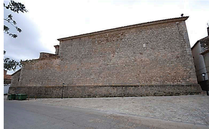
Fig VII.130: Fachada norte sin ninguna abertura para entrada de luz solar.
