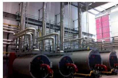
Figura 3: Detalle de sala técnica térmica de calderas, diseñada para las correctas funciones de mantenimiento
