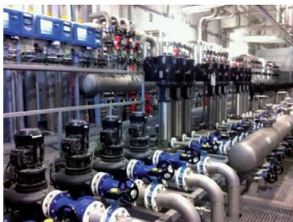
Figura 6: Detalle de salas fluidos, con sistemas de regulación mediante variadores electrónicos
