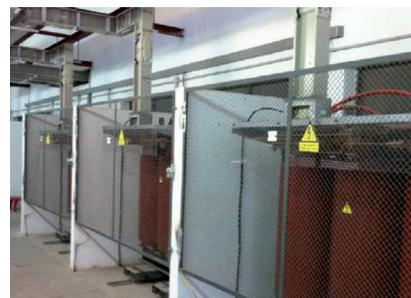
Figura 2: Detalle sistema de canalización electrificada y transformadores secos
