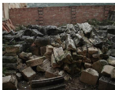
Figura 5.07. Parte de las piezas que formaban la bóveda que cubría el presbiterio situadas en el interior de éste en el suelo.
