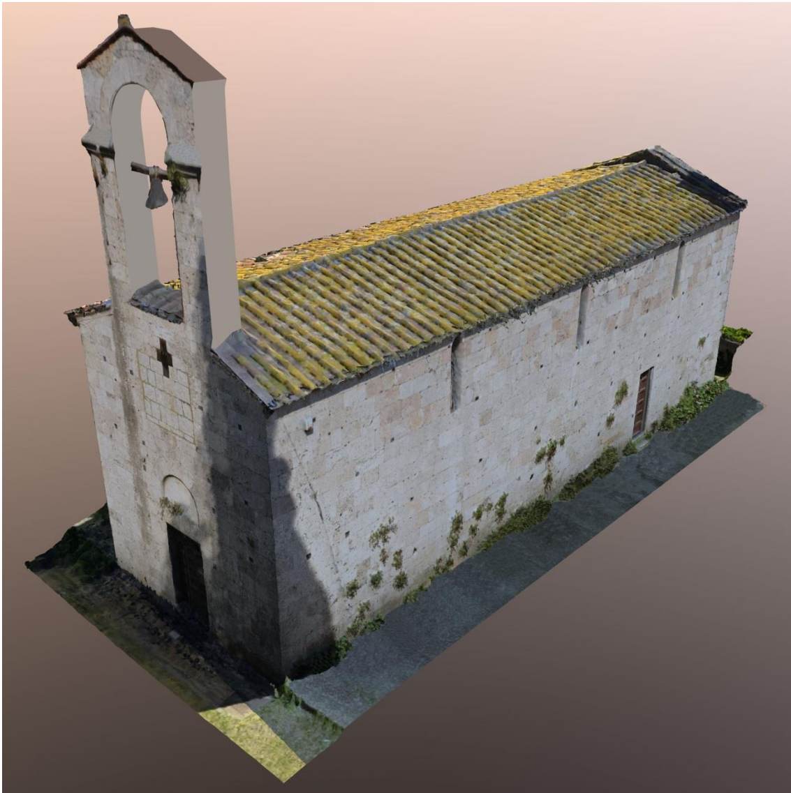
Figuras 8.44 y 8.45. Renders de la iglesia resultados de la integración obtenida mediante las dos tipologías de levantamiento objeto de estudio.
