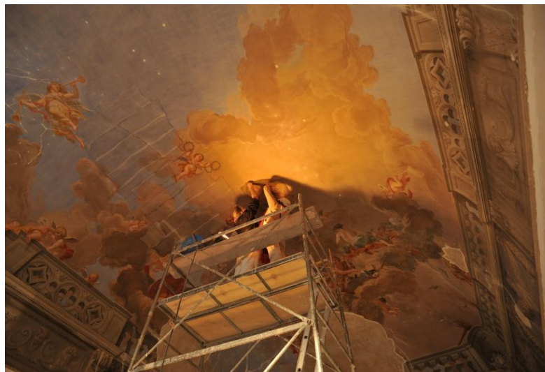
Figura 7.54. Imagen de la comprobación in situ de los A1 impresos del desarrollo de la bóveda en 2D.
