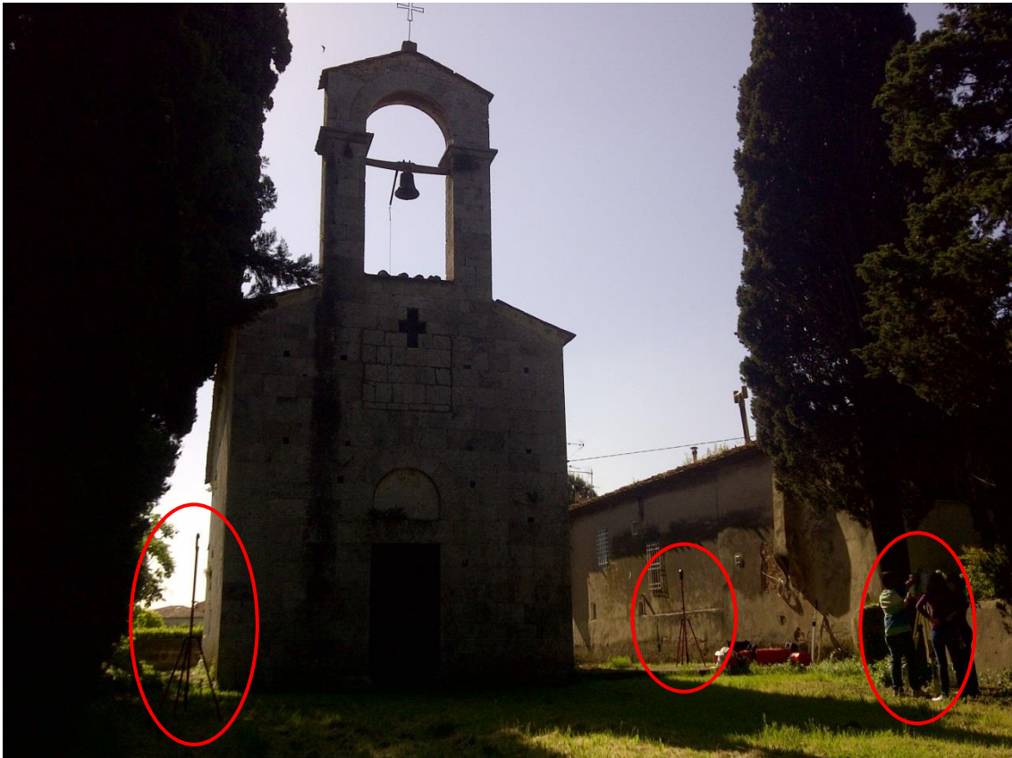
Figura 8.12. Imagen del proceso del escaneado 1100 (estación 11), en el cual se están capturando los target de las estaciones 600 y 1000.
