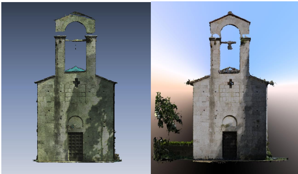
Figuras 8.38 y 8.39. A la izquierda, fachada principal obtenida mediante levantamiento con escáner láser. A la derecha, fachada principal desarrollada con el software Agisoft PhotoScan .
