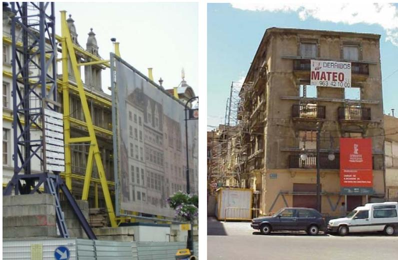
Imagen 1. Ejemplos de estabilizadores instalados en fachadas de edificios
