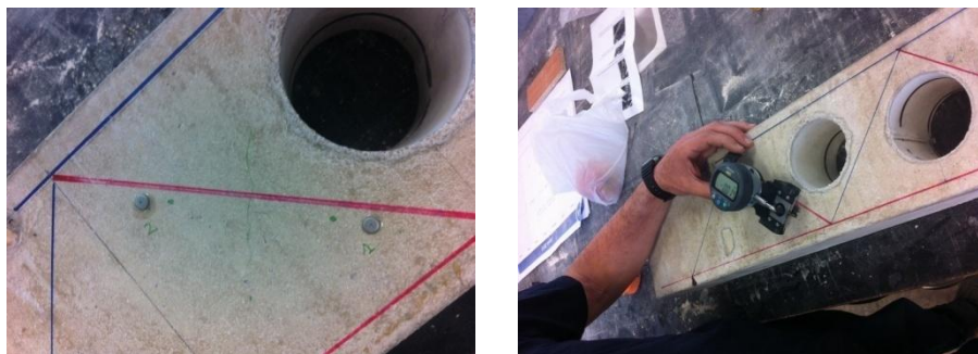
Imagen 4. 73 Colocación de DEMEC
