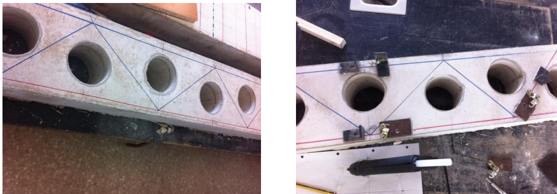
Imagen 4. 71 Grafiado de líneas de compresión y tracción, y colocación de captadores
