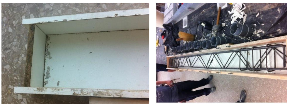
Imagen 4. 43 Preparación molde y colocación del armado
