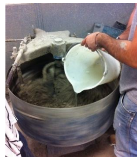
Imagen 4. 51 Disolución promotor adherente sólido y vertido de agua con superplastificante
