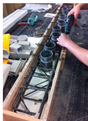
Imagen 4. 44 Fijación de tubos
