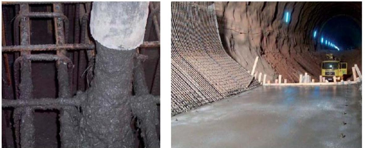
Imagen 2. 14 Hormigonado de la contraboveda.
