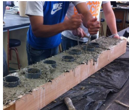
Imagen 4.47 Eliminación de coqueras
