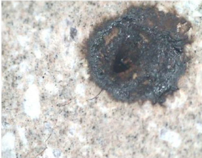
Imagen 2. 11 Fibra fundida y difundida en el hormigón
